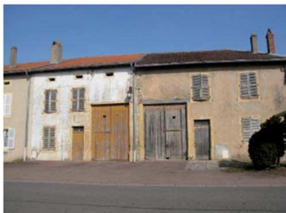
Fermes accolées le long de la rue principale
