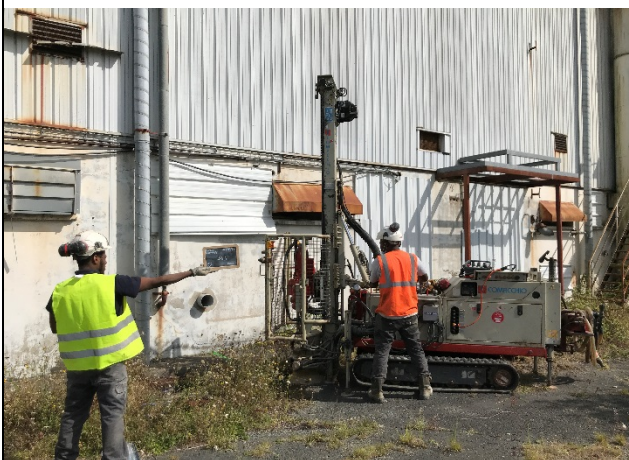
Vue d'ensemble de la zone d'intervention S13
