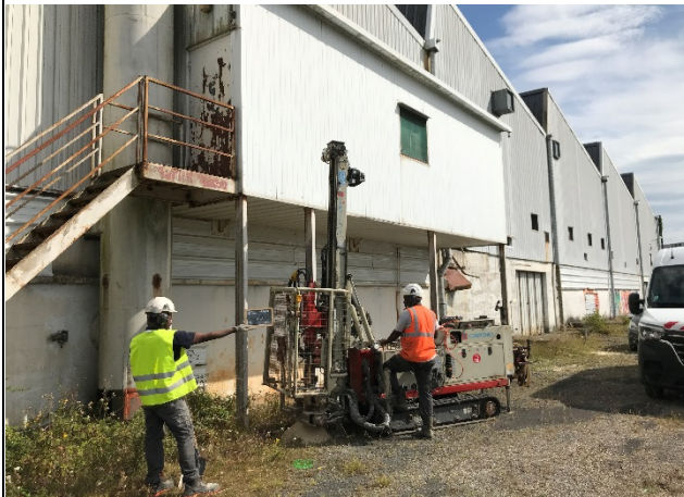
Vue d'ensemble de la zone d'intervention S12
