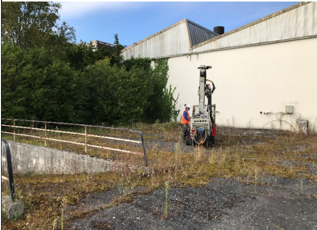
Vue d'ensemble de la zone d'intervention S22
