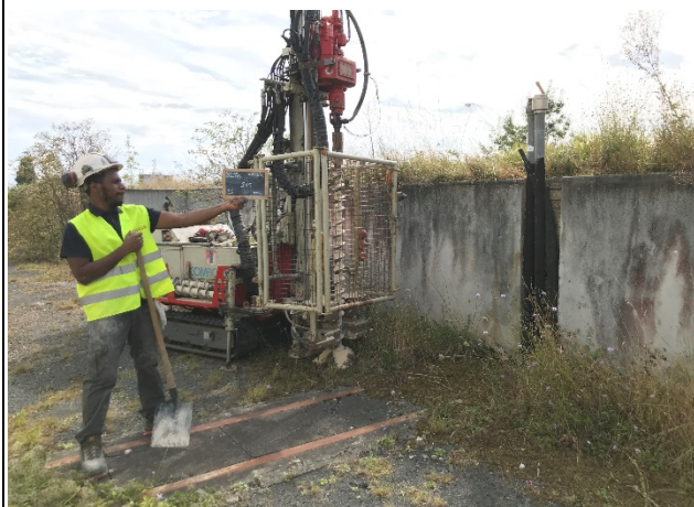
Vue d'ensemble de la zone d'intervention S15
