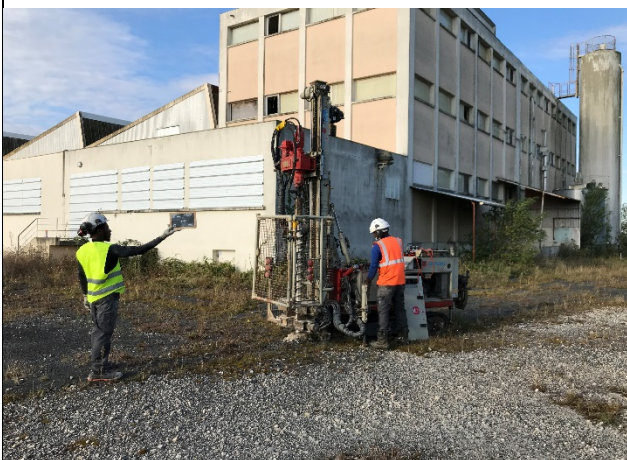
Vue d'ensemble de la zone d'intervention S19
