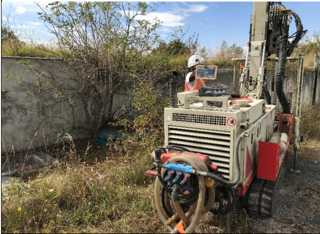
Vue d'ensemble de la zone d'intervention S14
