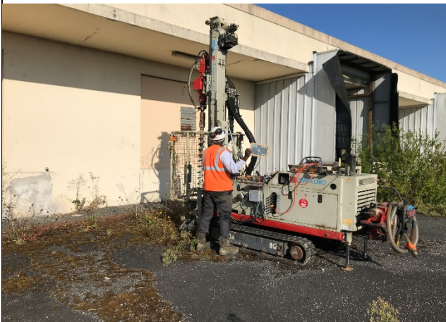
Vue d'ensemble de la zone d'intervention S2
