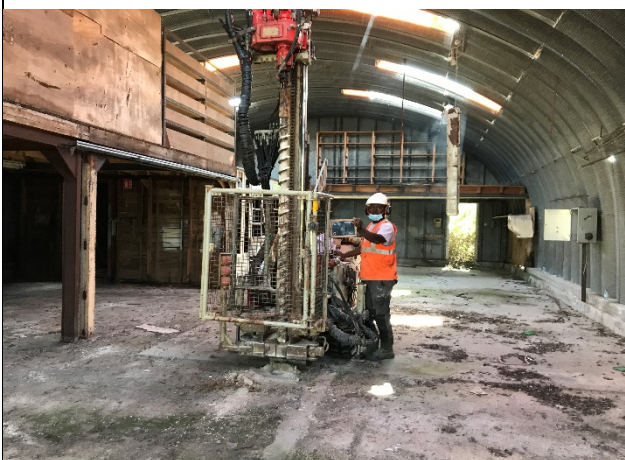
Vue d'ensemble de la zone d'intervention S7
