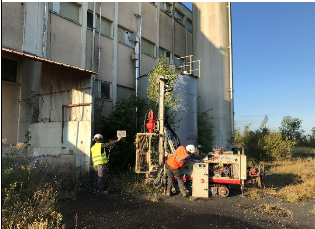
Vue d'ensemble de la zone d'intervention S18
