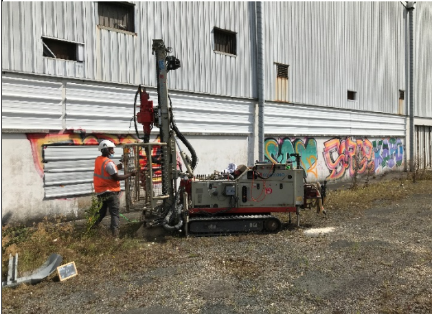
Vue d'ensemble de la zone d'intervention S10
