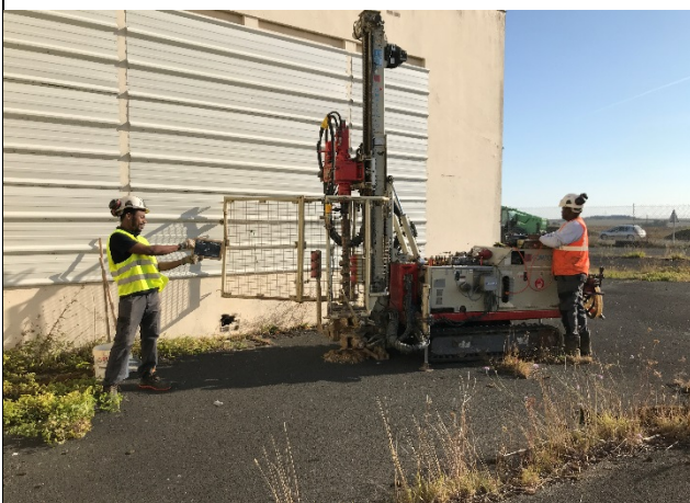
Vue d'ensemble de la zone d'intervention S1
