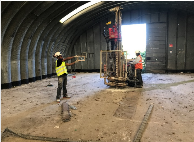
Vue d'ensemble de la zone d'intervention S6
