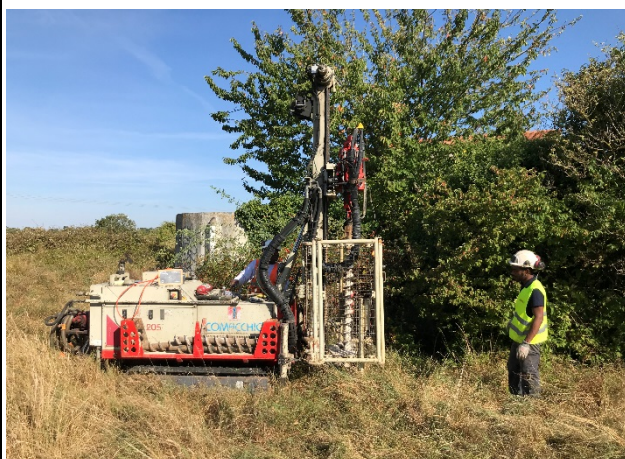
Vue d'ensemble de la zone d'intervention S3
