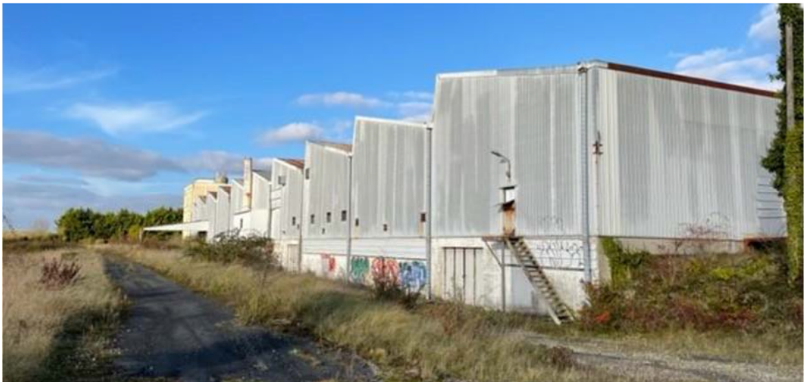
Vue de la partie atelier – accès sous-sol (au centre)
