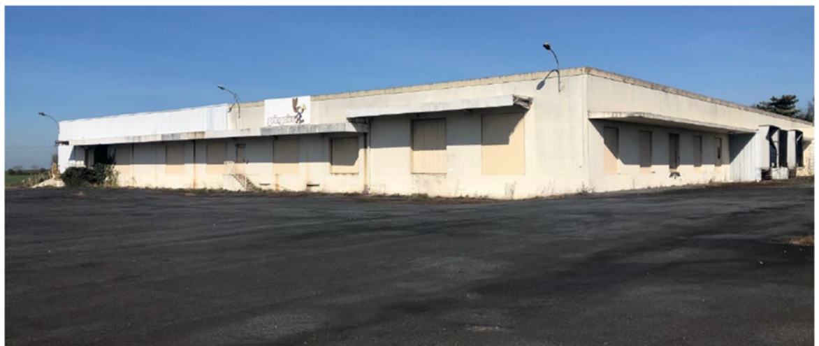
Vue de la partie magasin (Au Sud)
