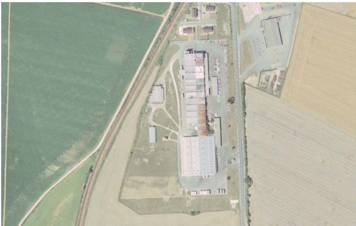
Vue aérienne du site datée de 1989 - Source : IGN
