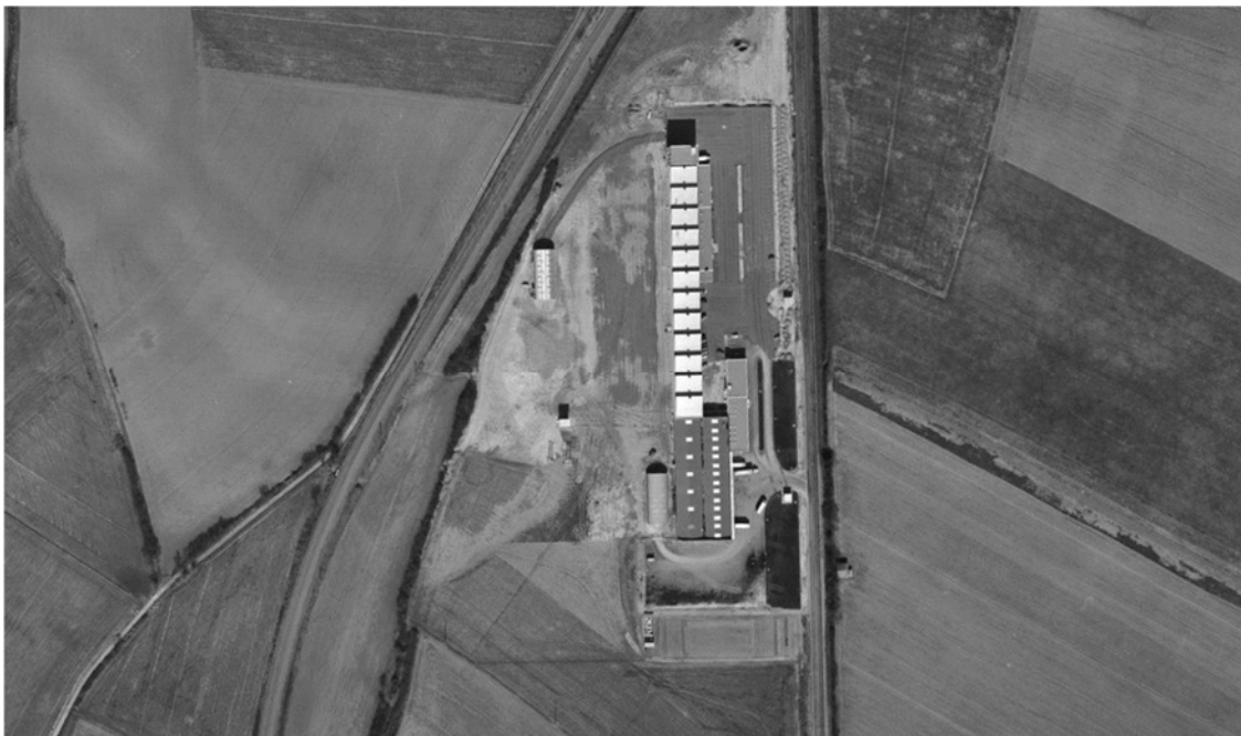
Vue aérienne du site datée de 1964 - Source : IGN
