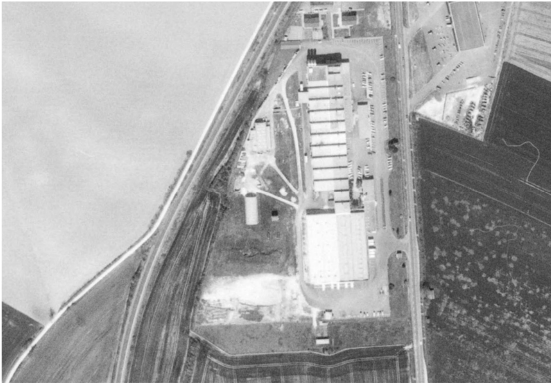
Vue aérienne du site datée de 1983 - Source : IGN
