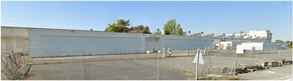
Vue de l'entrée du site (bureaux avec sous-sol)
