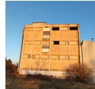
Bâtiment à étages
