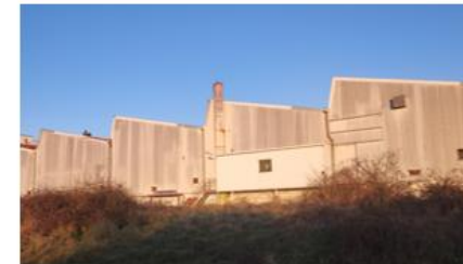
Bâtiment en rez-de-chaussée
