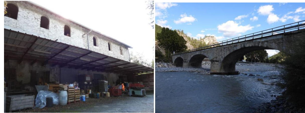
Figure 80 : Ancien corps de ferme et pont principal favorables au gîte © ECO-MED
