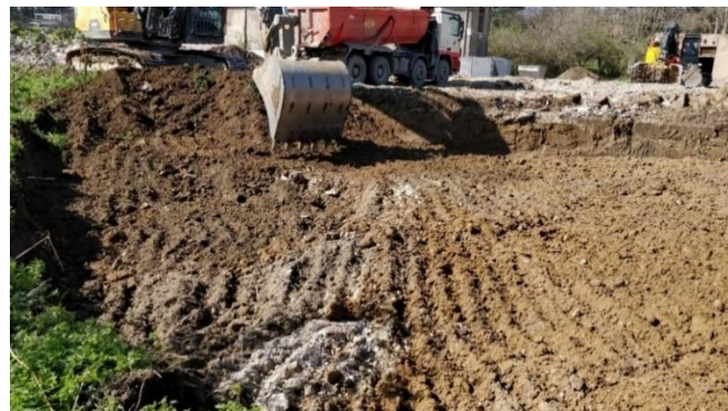
Figure 107 : Décaissage d'un massif de Renouée du Japon, S. Chaudet © EODD, 2021
