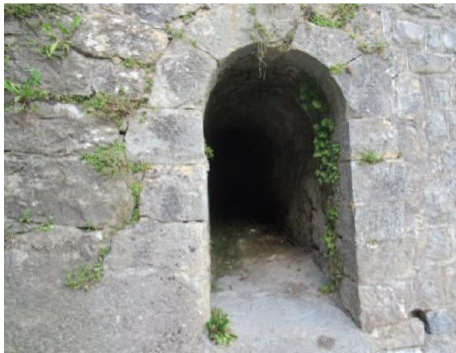
Figure 83 : Tunnel favorable au gîte d'espèces cavernicoles © ECO-MED
