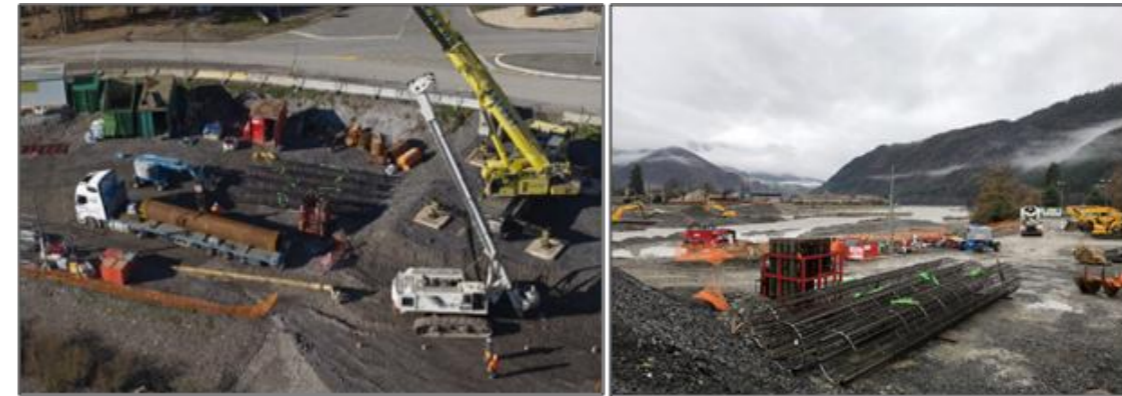
Figure 21 : Exemple de zone de stockage pieux
