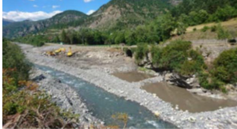
Exemple de bassin de décantation
