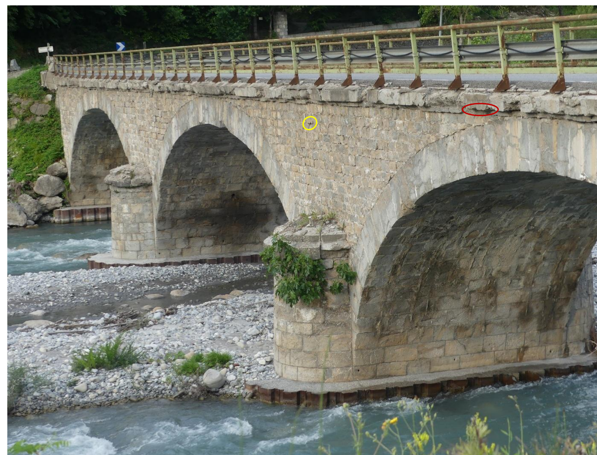
Figure 69 : Aval du pont avec un nid de Moineau cisalpin (rouge) et un nid de Bergeronnette de ruisseaux (jaune) © EODD
