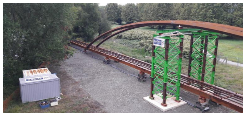
Figure 41 : Exemple de tours de palée anglaises pour l'assemblage de l'arc
