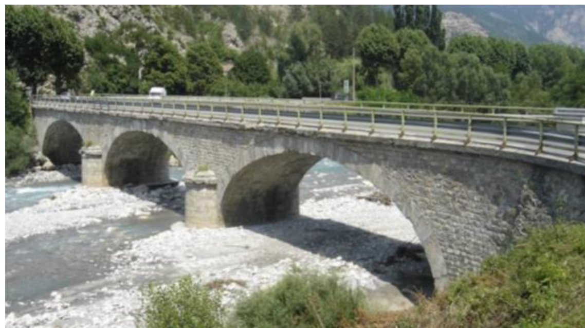
Figure 7 : Vue aérienne et photographie (depuis la rive gauche) du pont existant de la Trinité
