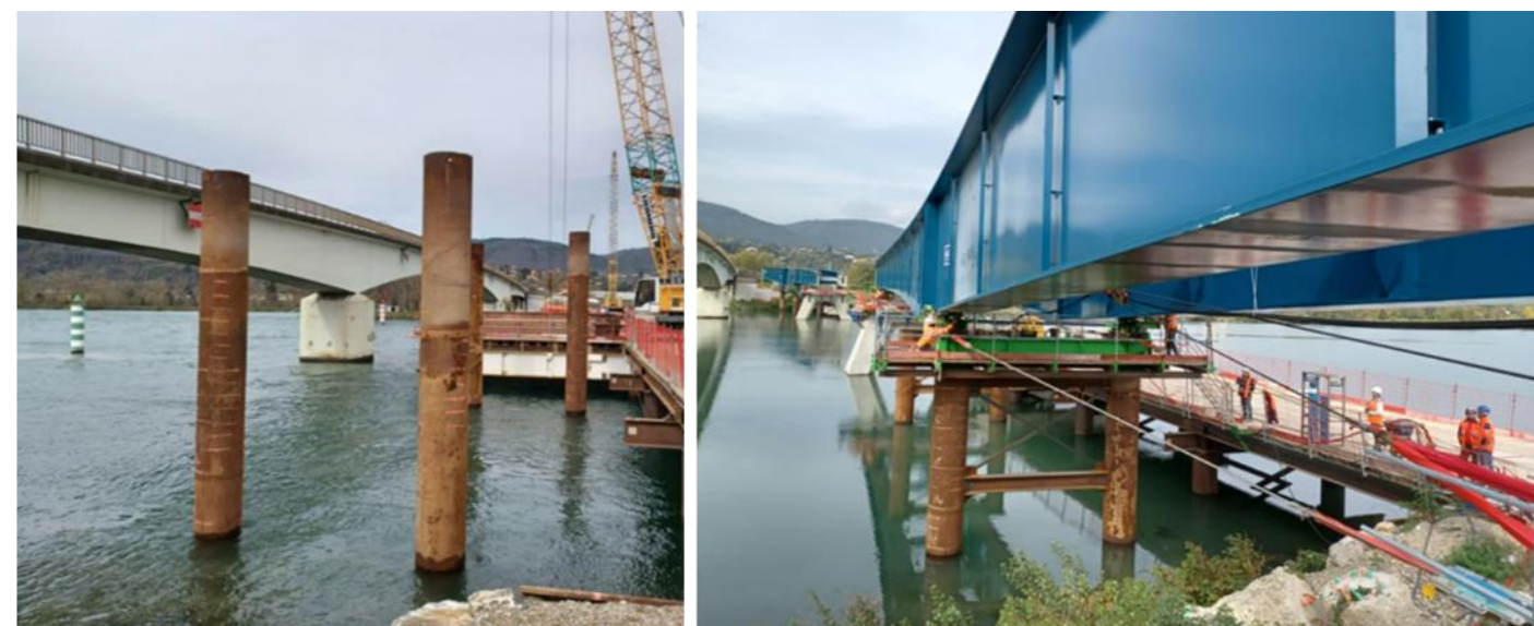
Figure 33 : Exemple de palées provisoires
