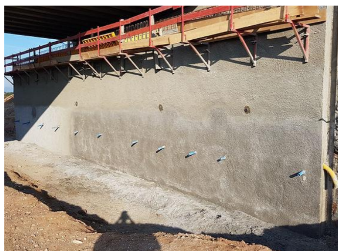
Figure 15 : Exemple de paroi clouée
