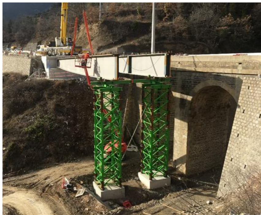
Figure 40 : Exemple de tours de palée anglaises pour l'assemblage de l'arc
