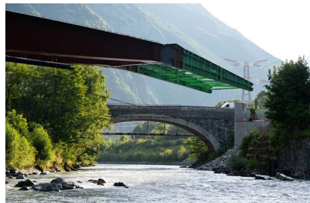
Figure 39 : Lançage du Pont de la Vena (Département de l'Isère – 2021)
