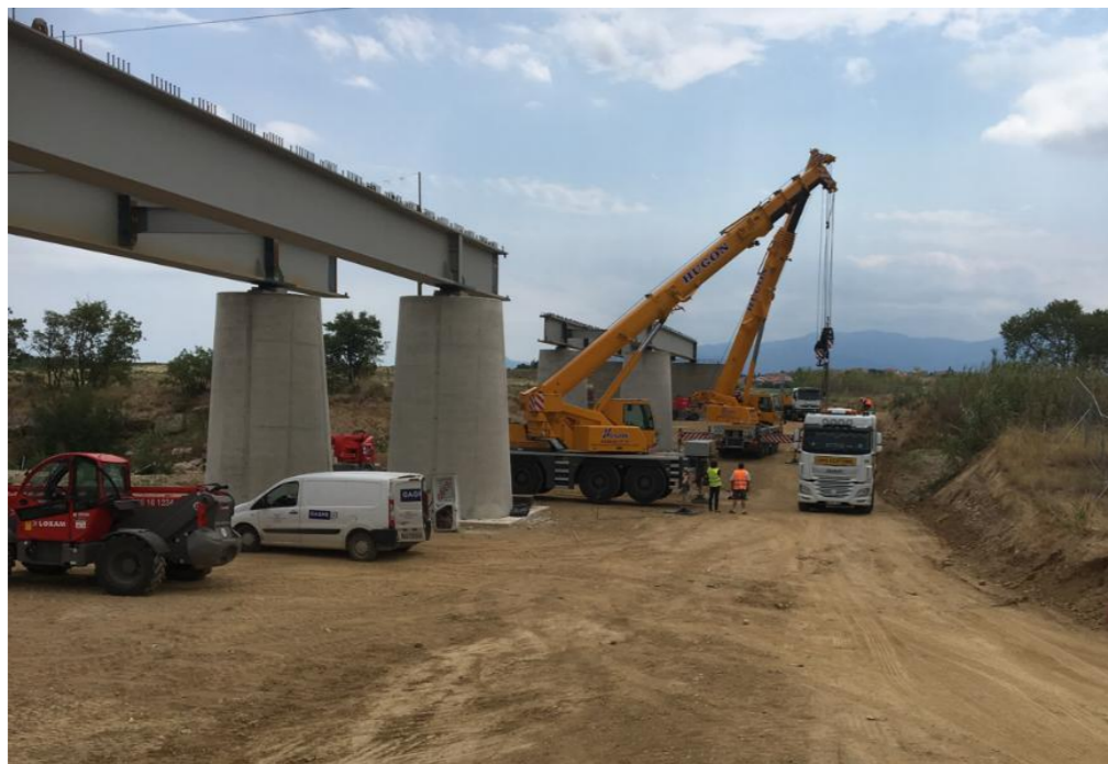
Figure 37 : Montage du tablier
