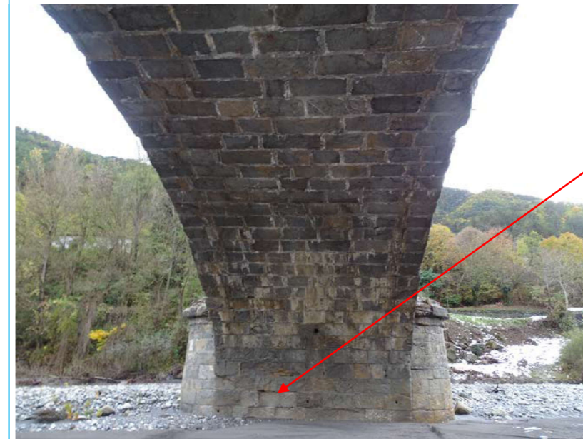
Photo 14 Intrados V2 - P2 Douelle humide Calcite active sur le rein Pierres érodées
