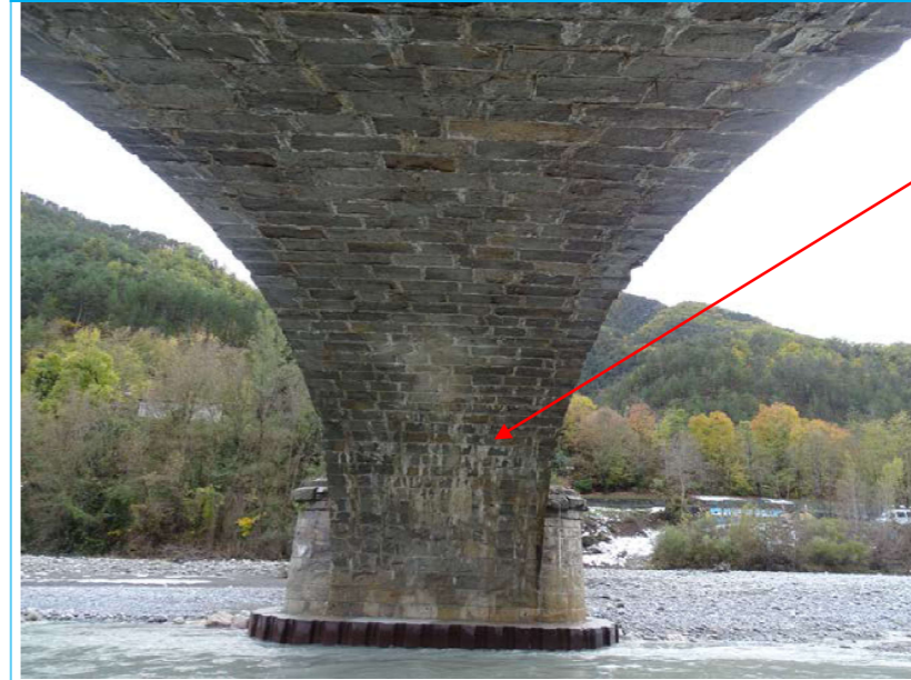
Photo 5 Intrados V1 - P1 Douelle humide Calcite active sur le rein
