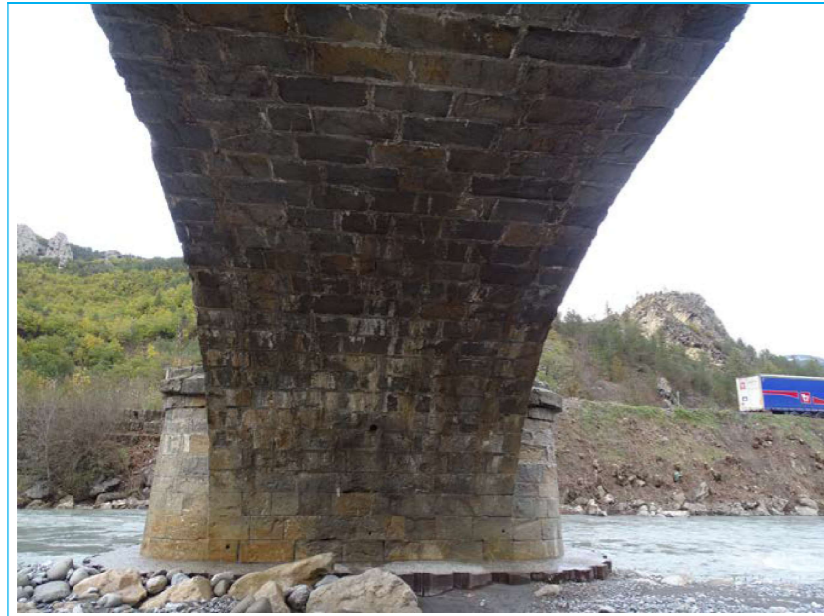
Photo 15 Intrados V2 - P1 Douelle humide Calcite active sur le rein
