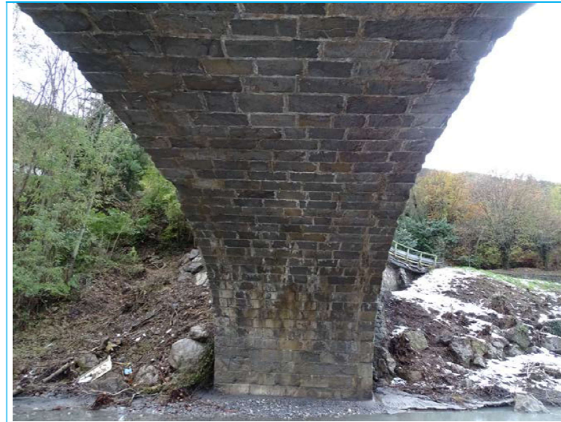
Photo 9 Intrados V3 – C3 Douelle humide Calcite active sur le rein
