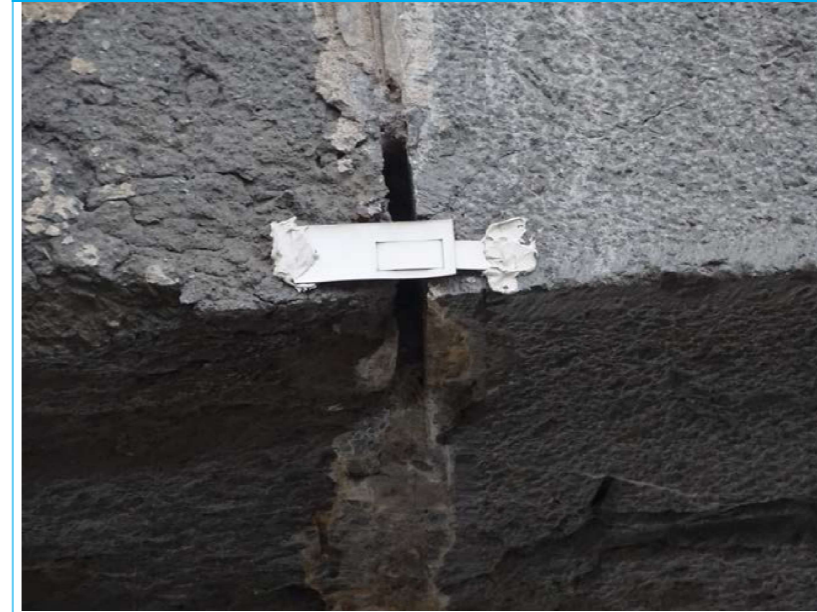
Photo 13 Bandeau Aval V2 en clef Jauge sur disjointoiement (aucune fissure)
