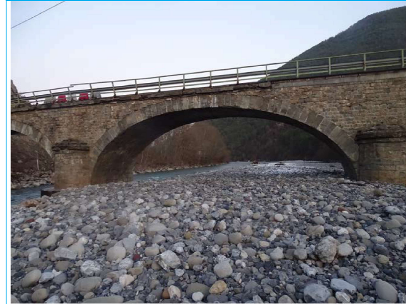
Photo 113 Lit du cours d'eau V2
