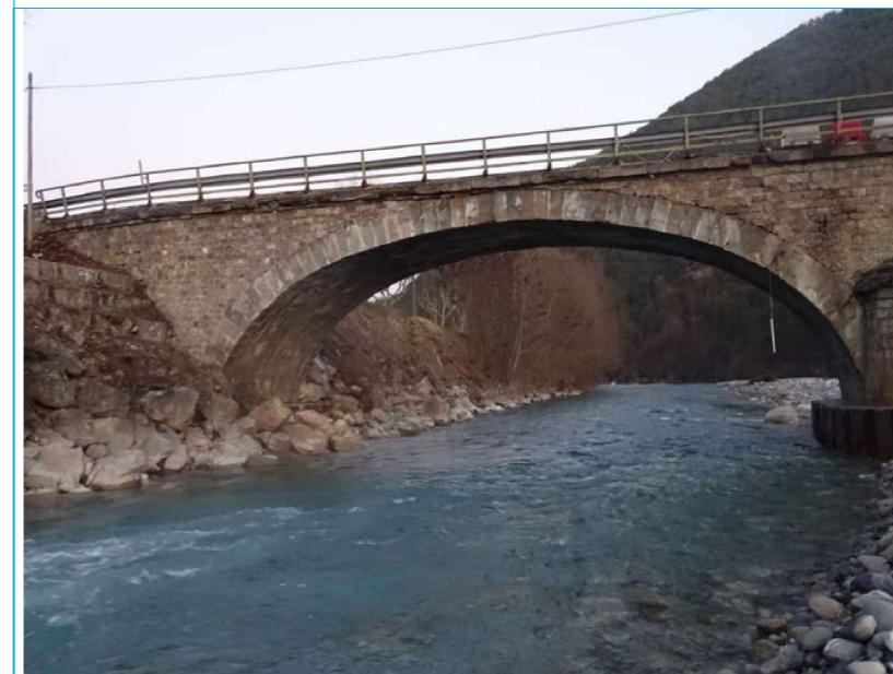
Photo 114 Lit du cours d'eau V1
