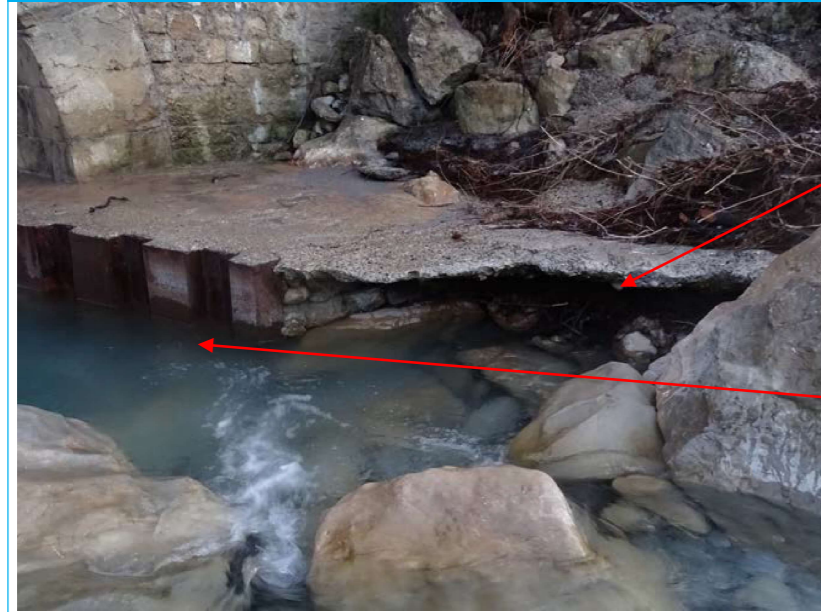
Photo 111 Inspection subaquatique Culée C3 Protection Affouillement 3,5 x 0.7 x 1 m Affouillement sous les palplanches (40 x 70 x 20 cm)
