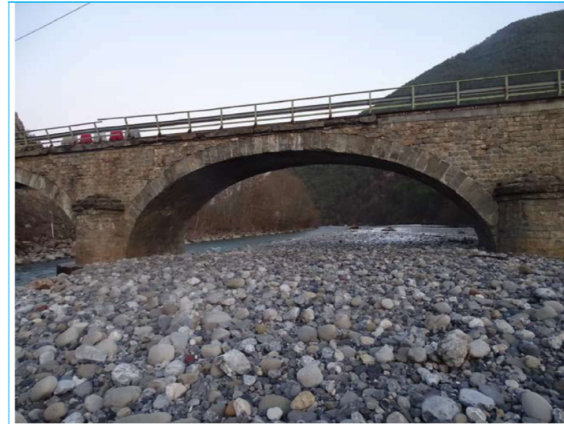
Photo 113 Lit du cours d'eau V2
