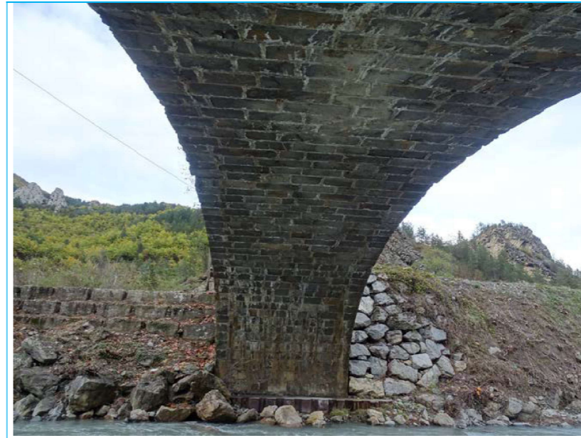
Photo 17 Intrados V1 - C0 Douelle humide Calcite active sur le rein
