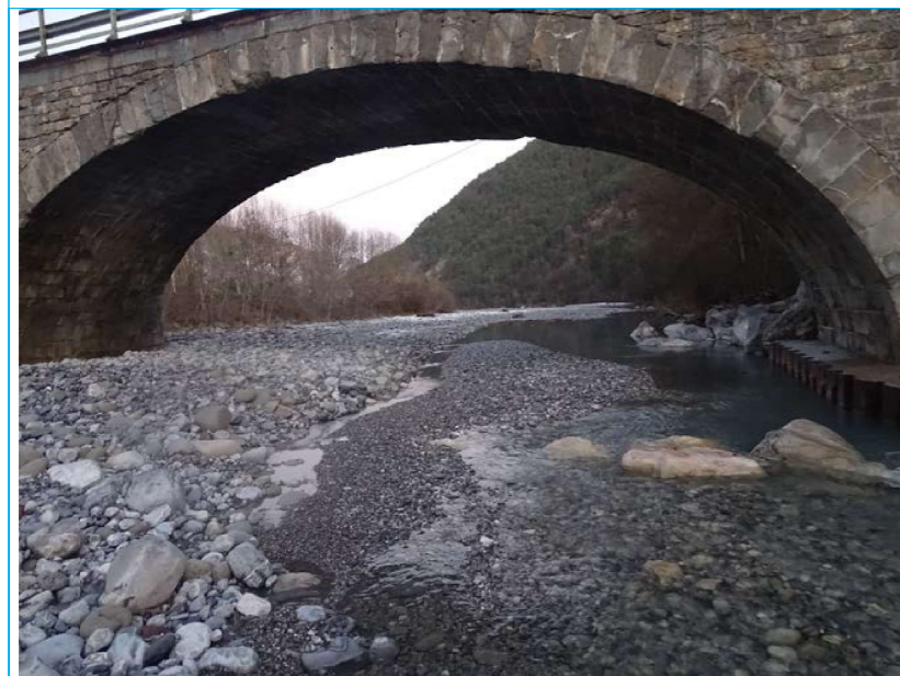
Photo 112 Lit du cours d'eau V3
