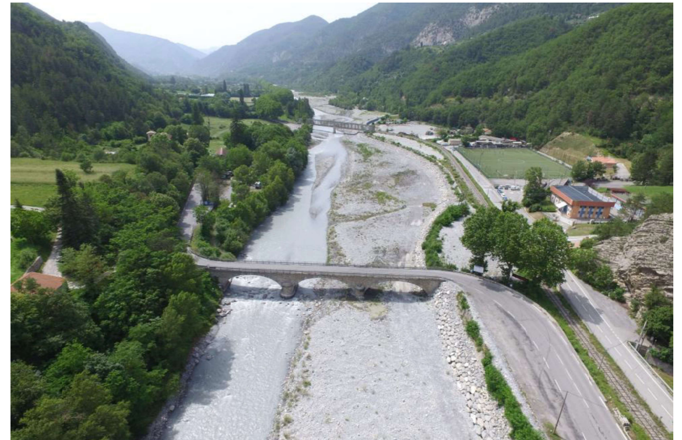
Figure 2 : Configuration actuelle du site vue de l'aval (pont existant et pont SNCF)
