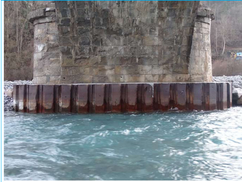
Photo 103 Inspection subaquatique Pile P1 face C0 Soubassement palplanches
