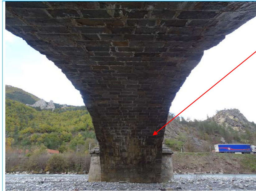
Photo 7 Intrados V3 – P2 Douelle humide Calcite active sur le rein
