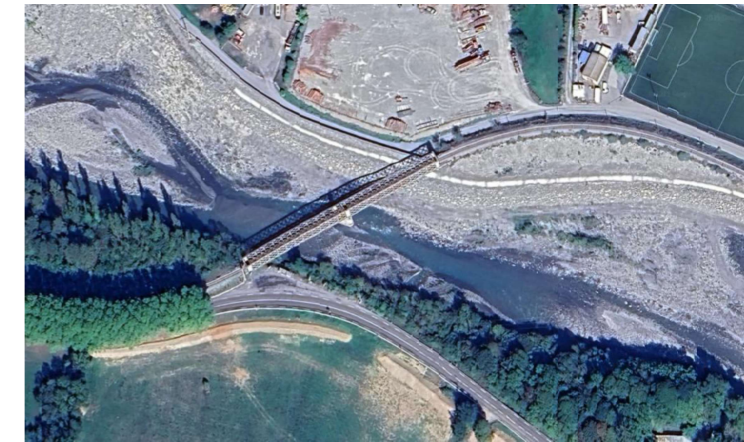
Figure 15 : Pont SCNF - vue aérienne
