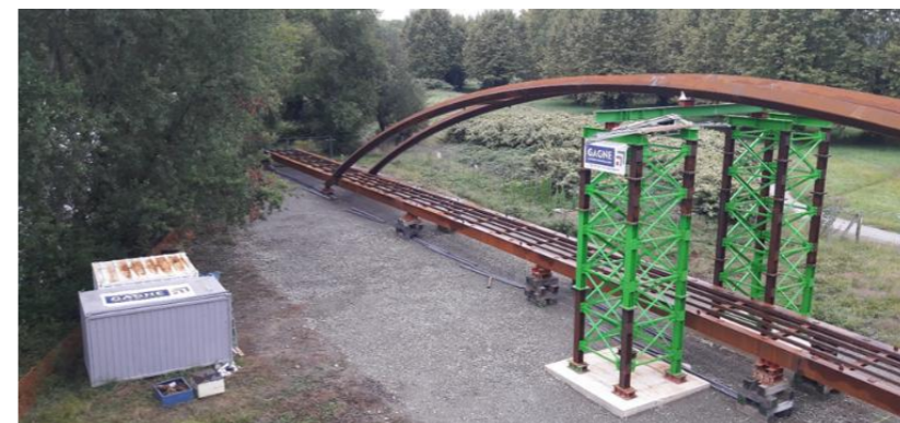
Figure 40 : Exemple de tours de palée anglaises pour l'assemblage de l'arc
