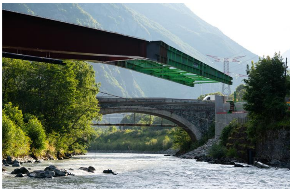
Figure 38 : Lançage du Pont de la Vénéa (Département de l'Isère – 2021)
