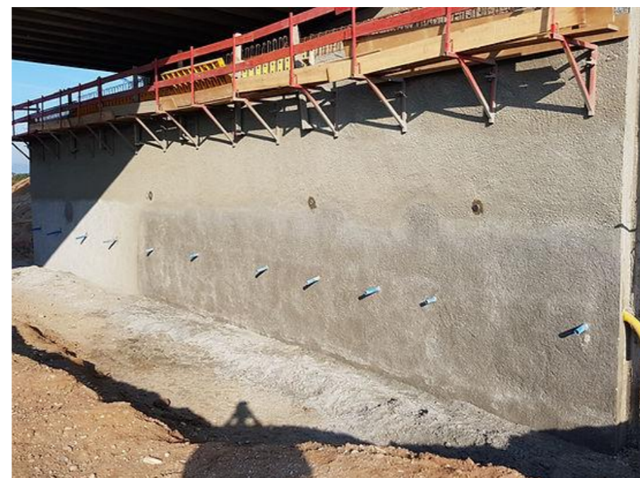
Figure 14 : Exemple de paroi clouée
