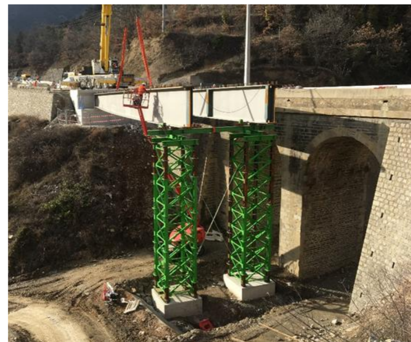
Figure 39 : Exemple de tours de palée anglaises pour l'assemblage de l'arc
