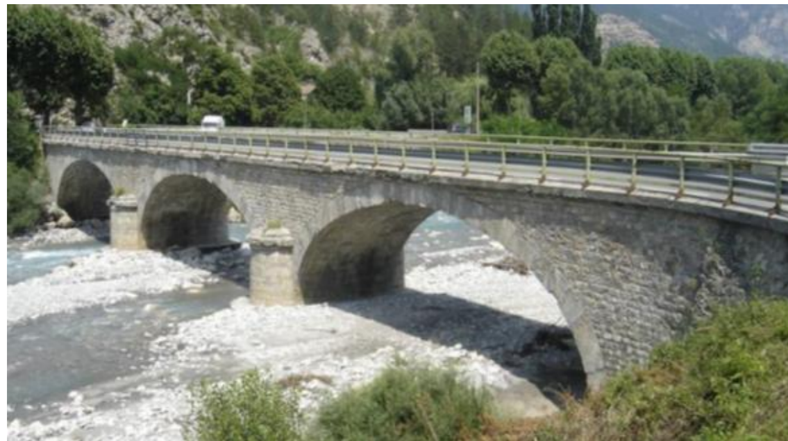
Figure 6 : Vue aérienne et photographie (depuis la rive gauche) du pont existant de la Trinité
