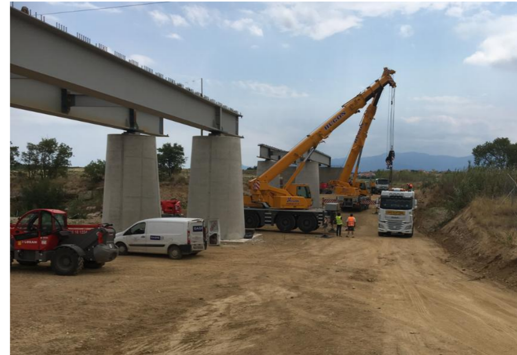
Figure 36 : Montage du tablier
