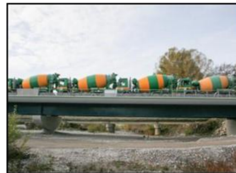
Figure 60 : Transport et mise en œuvre du béton
