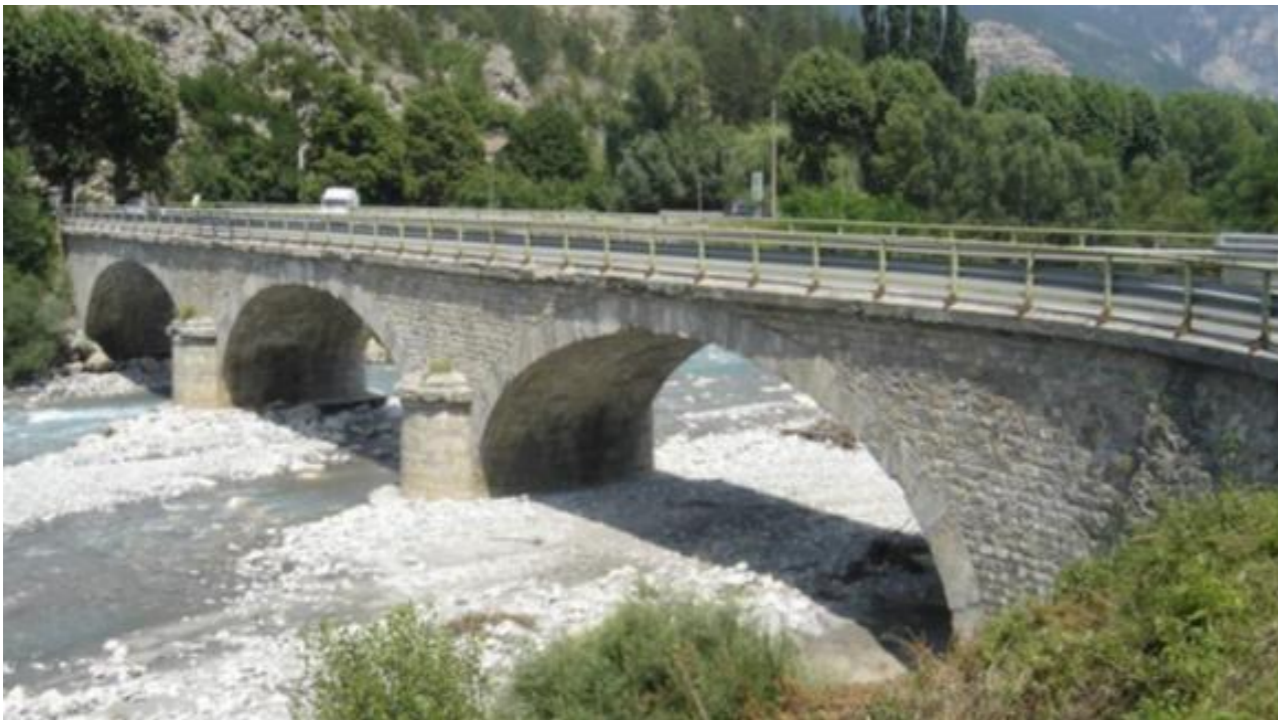
Figure 9 : Vue aérienne et photographie (depuis la rive gauche) du pont existant de la Trinité
