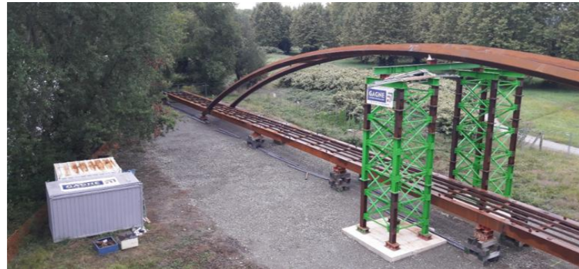
Figure 68 : Exemple de tours de palée anglaises pour l'assemblage de l'arc
