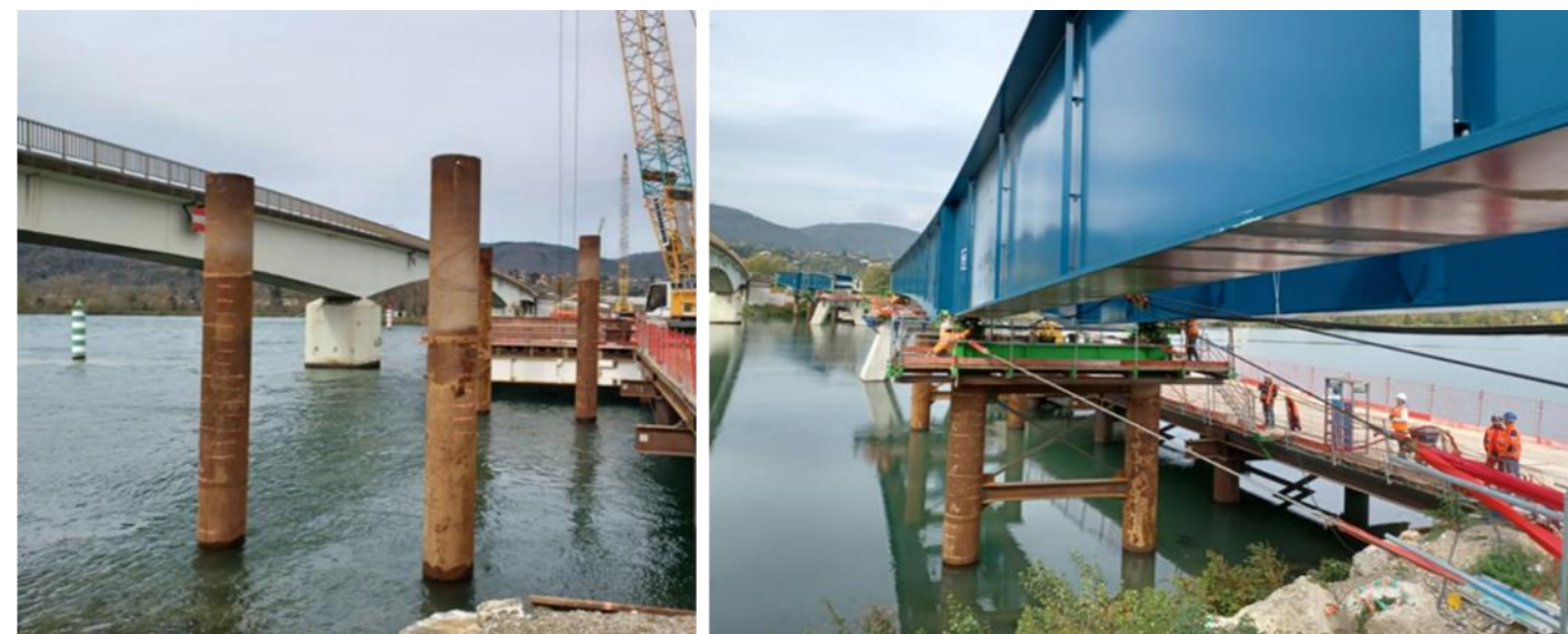
Figure 54 : Exemple de palées provisoires
