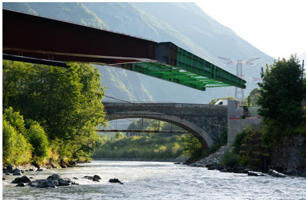
Figure 65 : Lançage du Pont de la Véna (Département de l'Isère – 2021)
