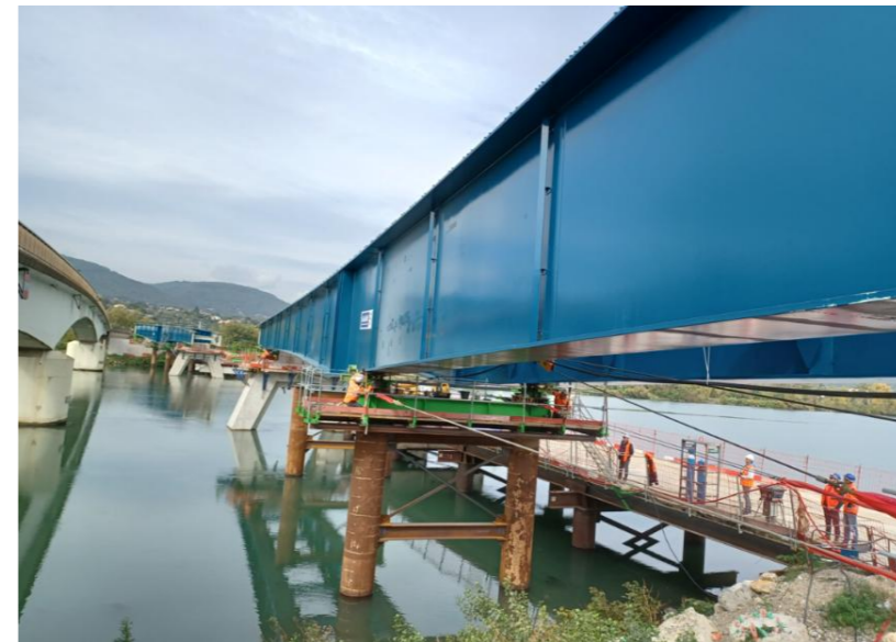
Figure 66 : Exemple de lançage d'un tablier
