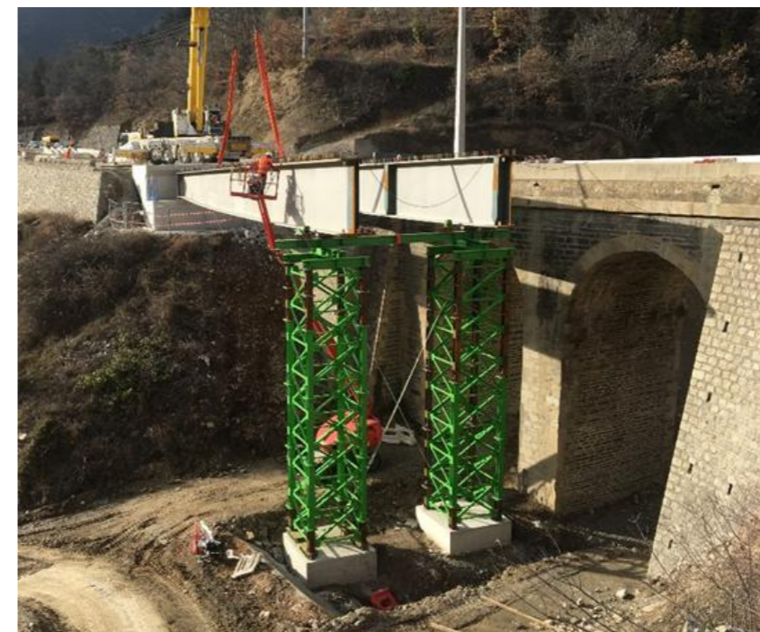
Figure 67 : Exemple de tours de palée anglaises pour l'assemblage de l'arc
