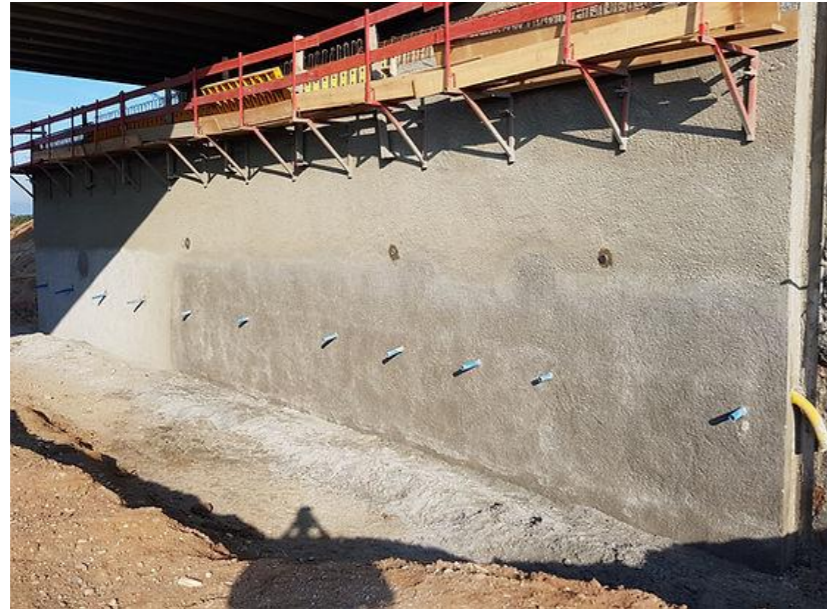
Figure 32 : Exemple de paroi clouée
