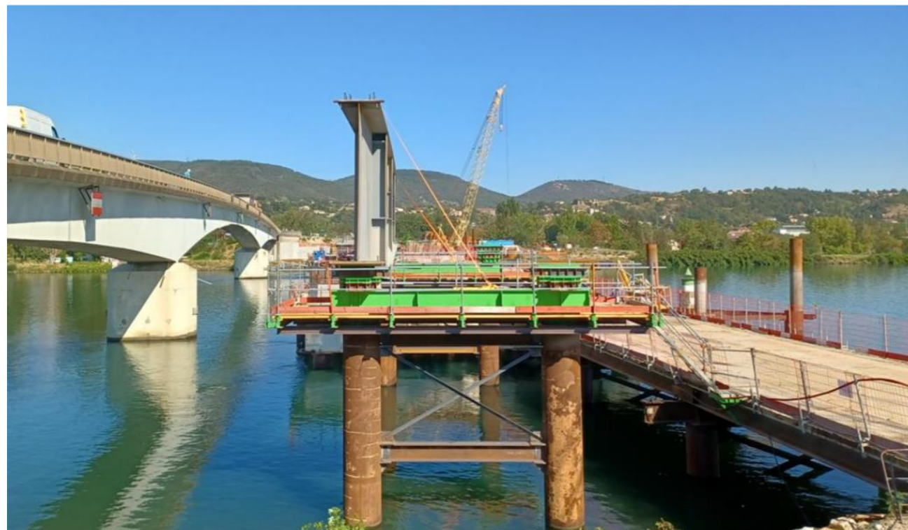
Figure 56 : Exemple de chevêtre métallique
