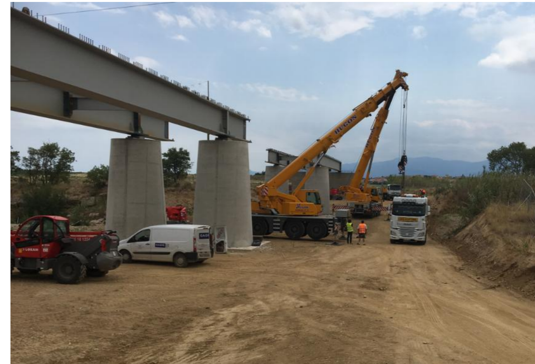
Figure 63 : Montage du tablier
