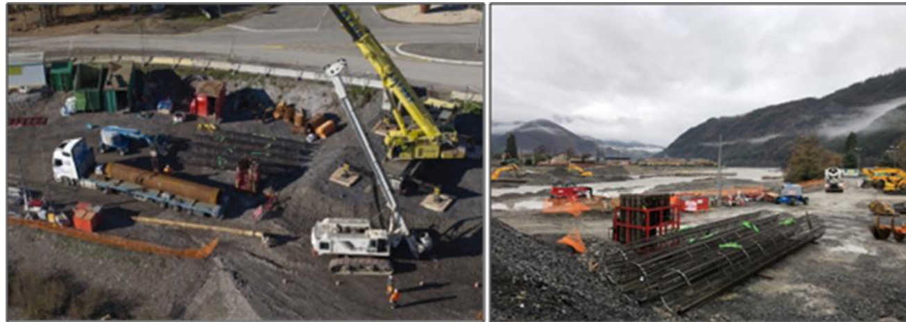
Figure 45 : Exemple de zone de stockage pieux
