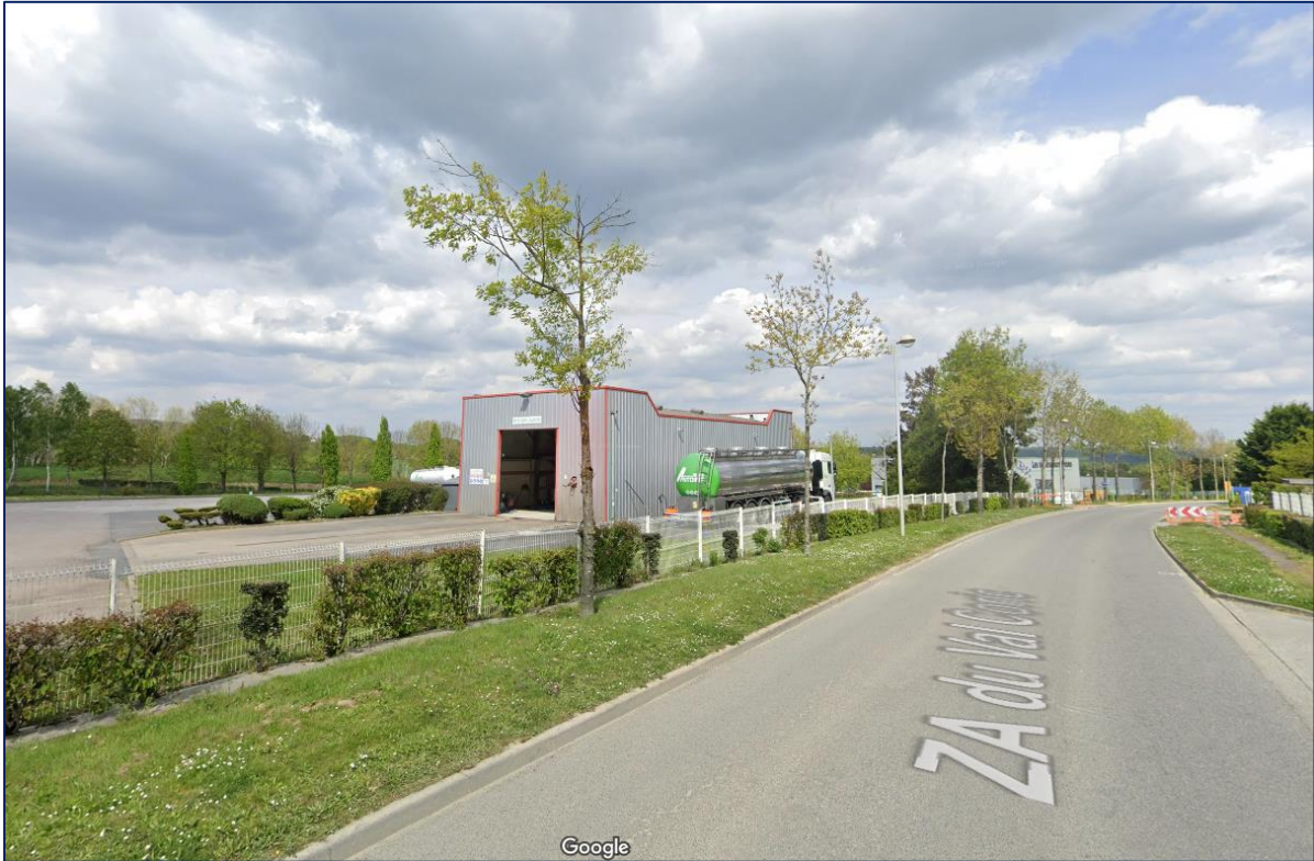
Figure 2 : Aperçu de la station de lavage
