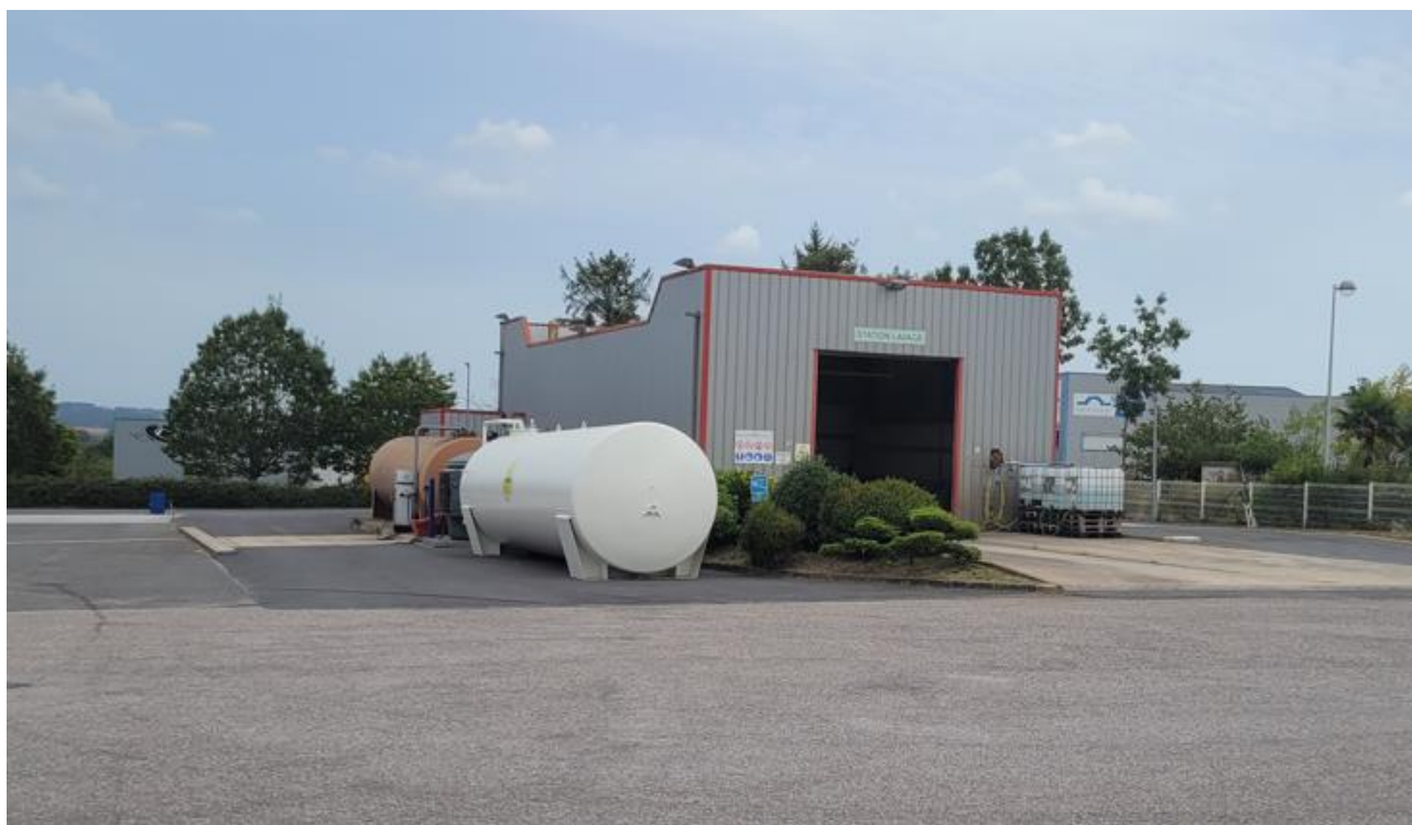
Photo 1 : Bâtiment de lavage et citernes carburants
