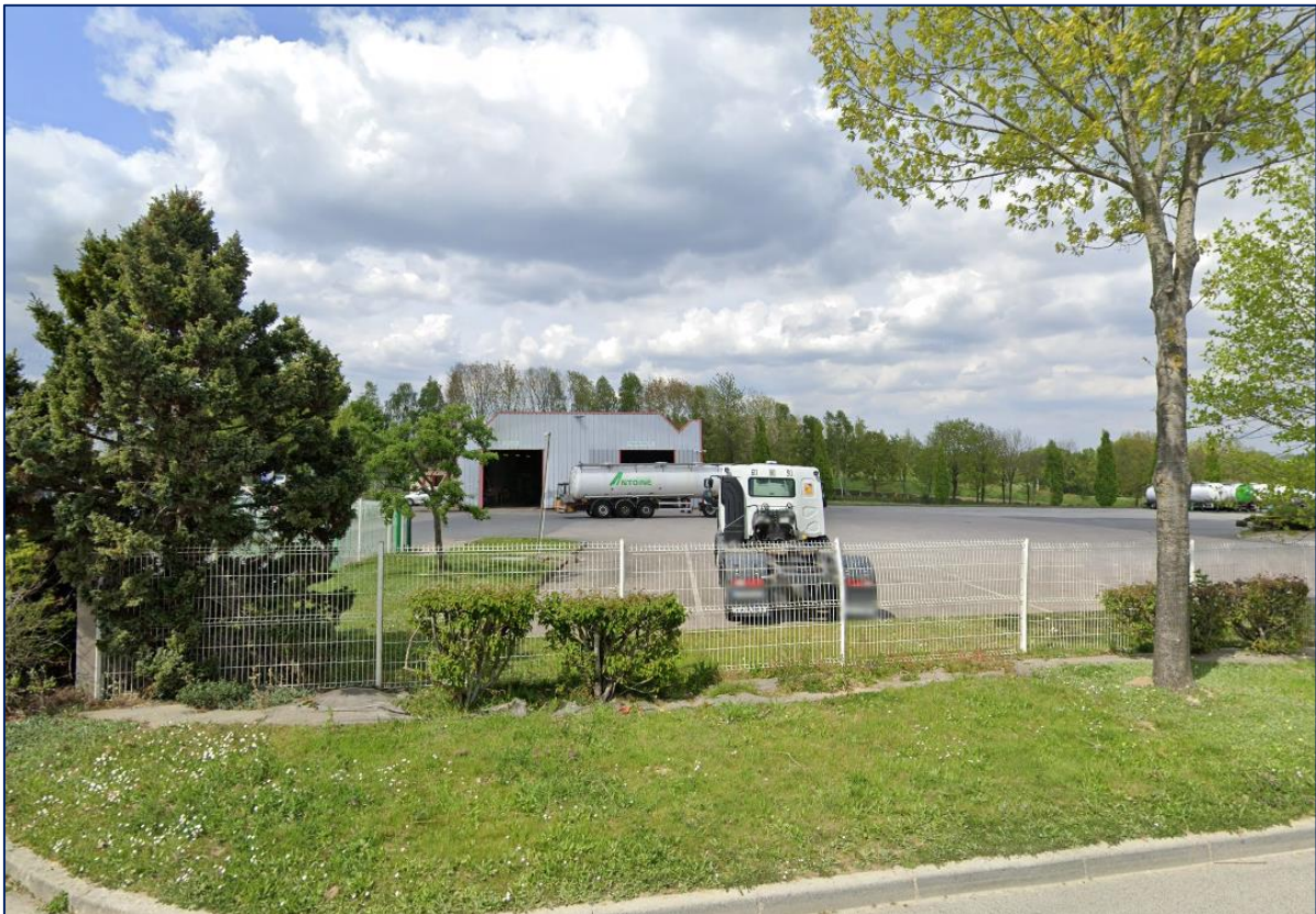
Figure 3 : Aperçu des ateliers et bureaux
