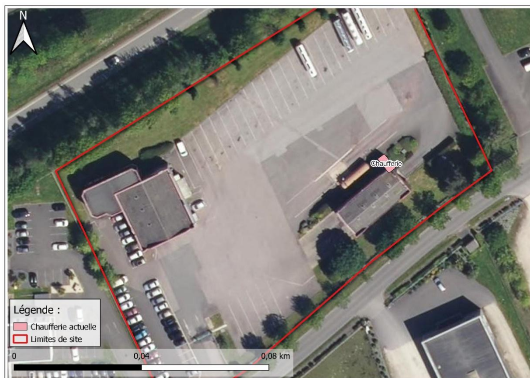
Figure 10 : Localisation des installations de combustion en l'état
