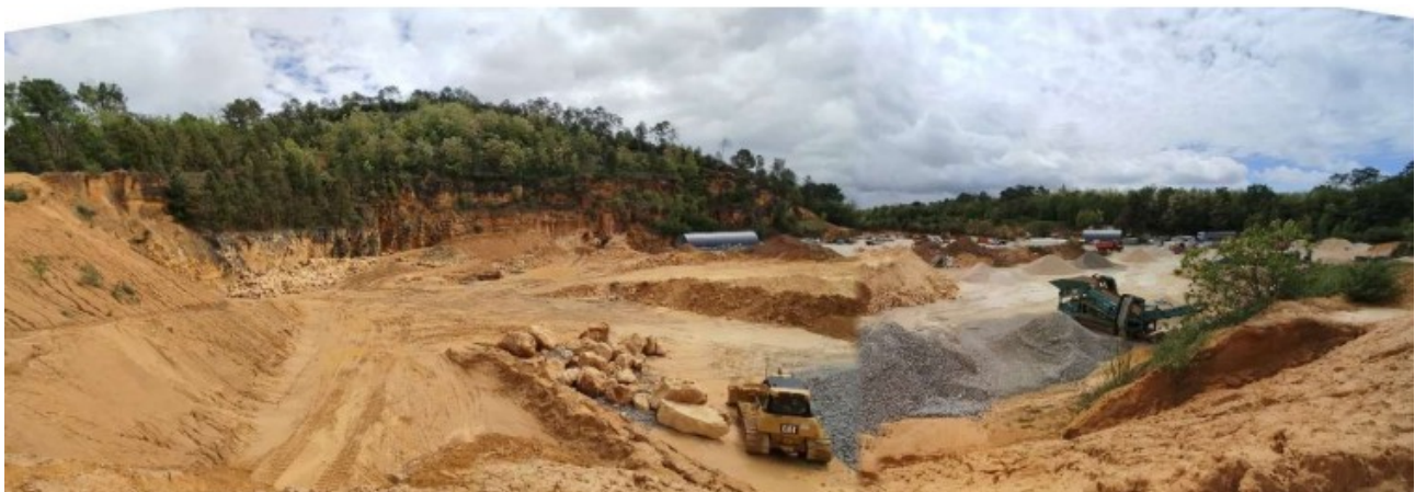
Vue d'ensemble de la carrière actuelle - Extrait de la page 70 de l'étude d'impact
