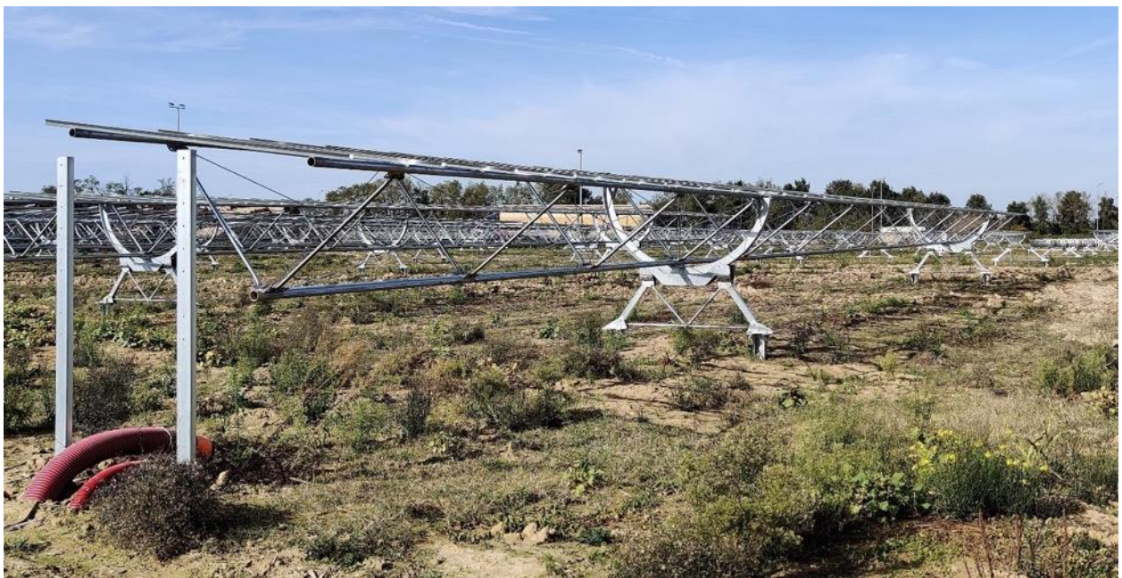
Figure 39 : Exemple de structure trackers (source : REDEN)
