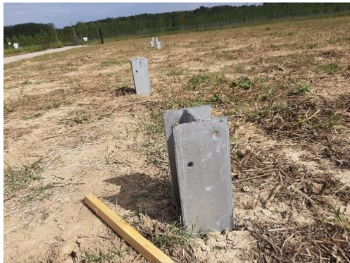
Figure 40 : Exemple de pieux battus (source : REDEN)
