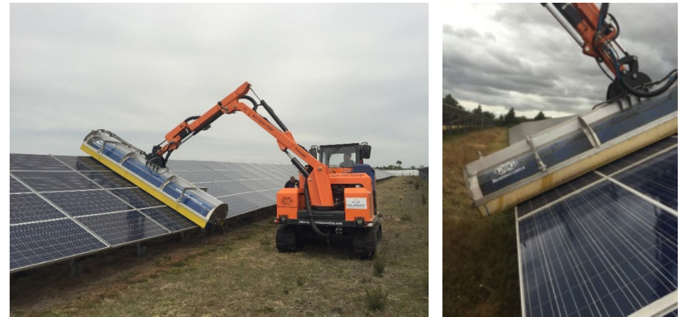
Figure 37 - Exemple de maintenance des panneaux. Source: Reden
