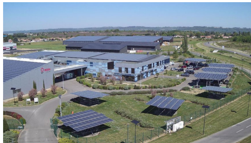
Figure 1 - Siège du groupe REDEN-Roquefort (47) (Source : REDEN)
