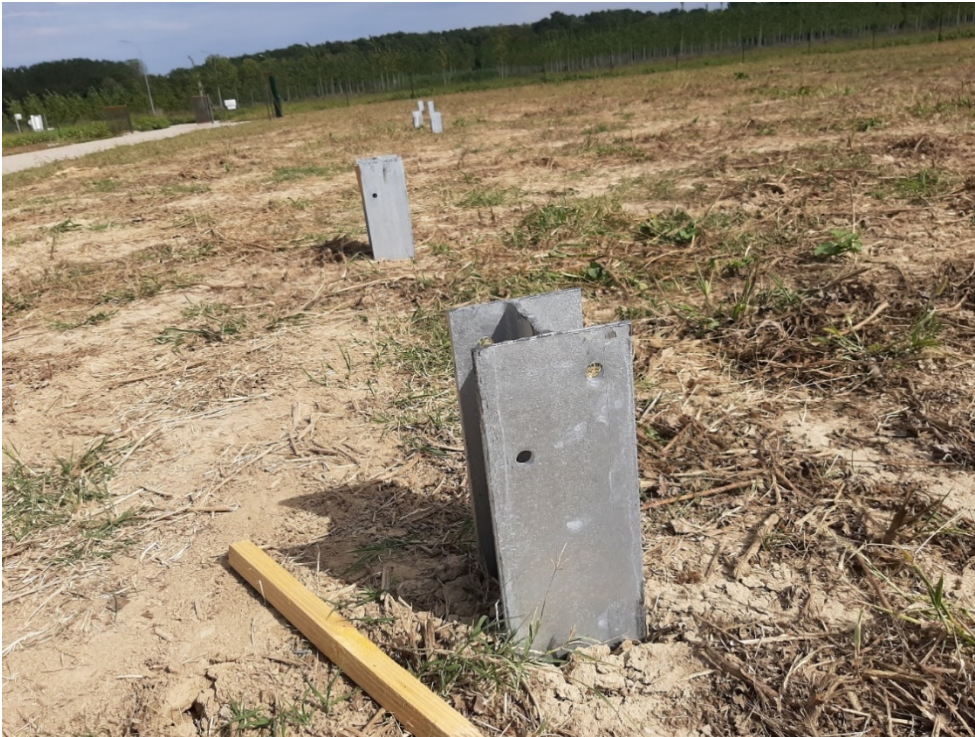
Figure 24 - Exemple de pieux battus (source : REDEN)
