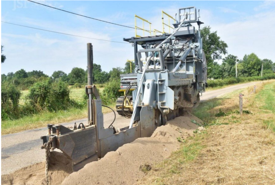
Figure 33 - Exemple de réalisation d'une tranchée pour raccordement souterrain.
