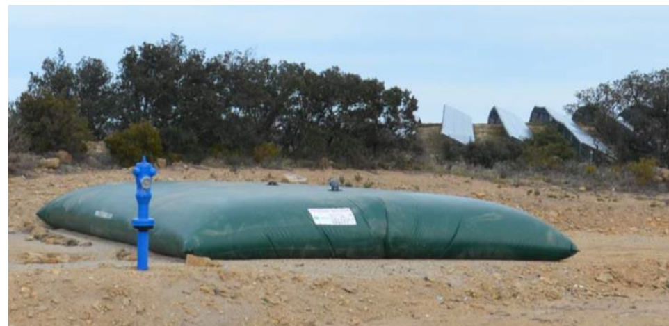
Figure 34 - Réserve incendie. Source : Reden
