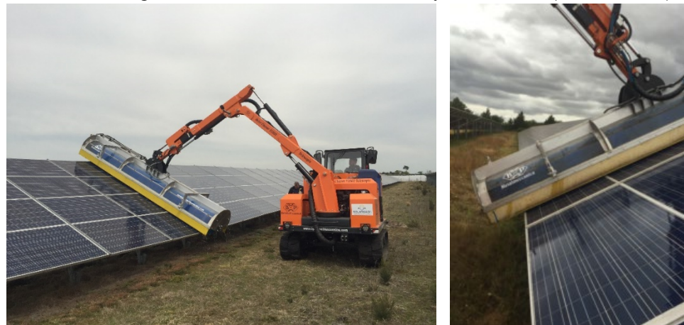
Figure 46 - Exemple de maintenance des panneaux. Source: Reden
