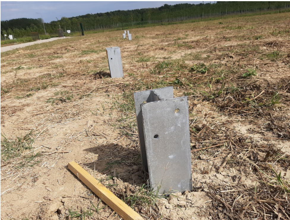
Figure 33 - Exemple de pieux battus (source : REDEN)
