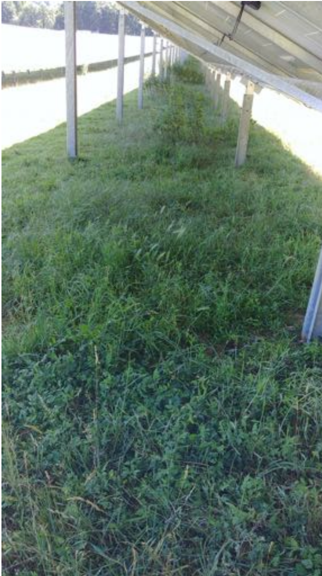
Figure 40 : Herbe sous les panneaux (Photo : Reden©)
