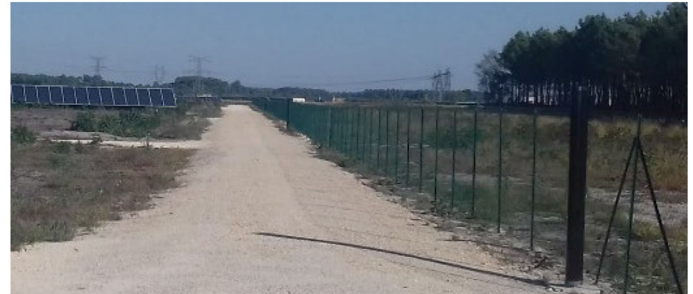
Figure 40 - Exemple de bornes de détection en bordure de clôture. Source : Reden
