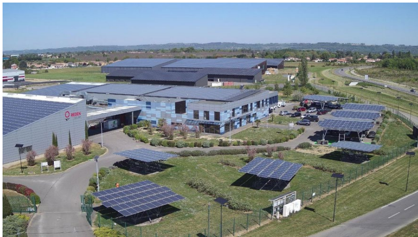
Figure 14 - Siège du groupe REDEN-Roquefort (47) (Source : REDEN)
