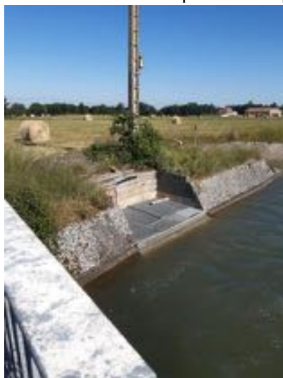
Figure 54 ancien point de pompage de M Ricard situé sur la parcelle
