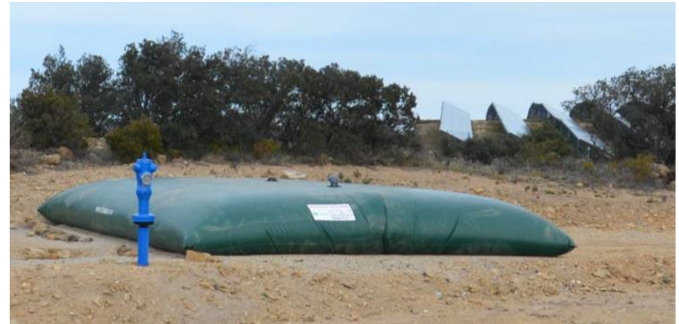
Figure 43 - Réserve incendie. Source : Reden
