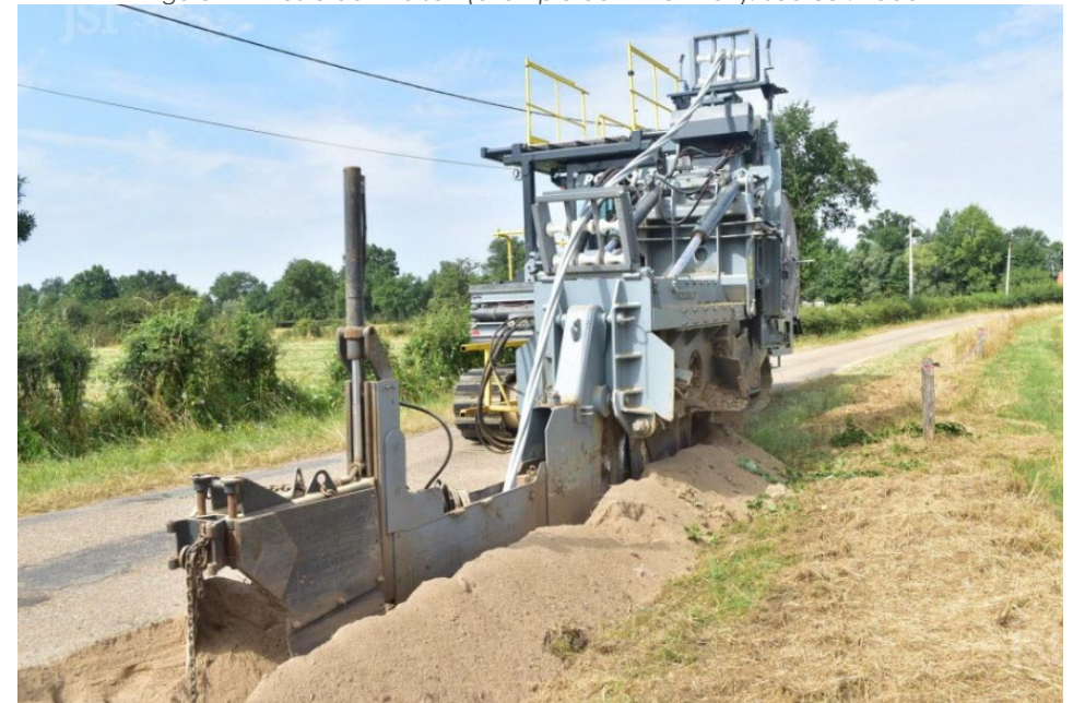
Figure 42 - Exemple de réalisation d'une tranchée pour raccordement souterrain.
