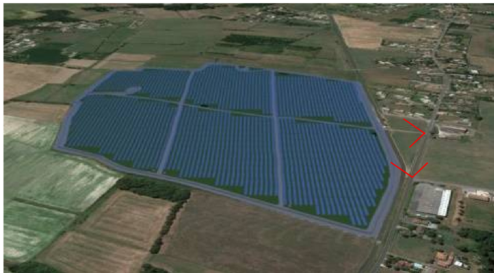
Vue depuis le Nord du site
