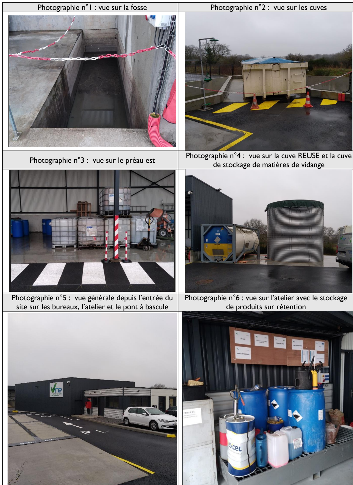
Figure 8 : Reportage photographique sur site après aménagement
