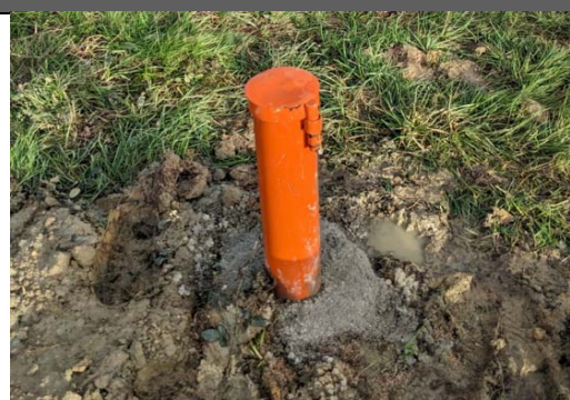
PHOTOGRAPHIE DE L'OUVRAGE
