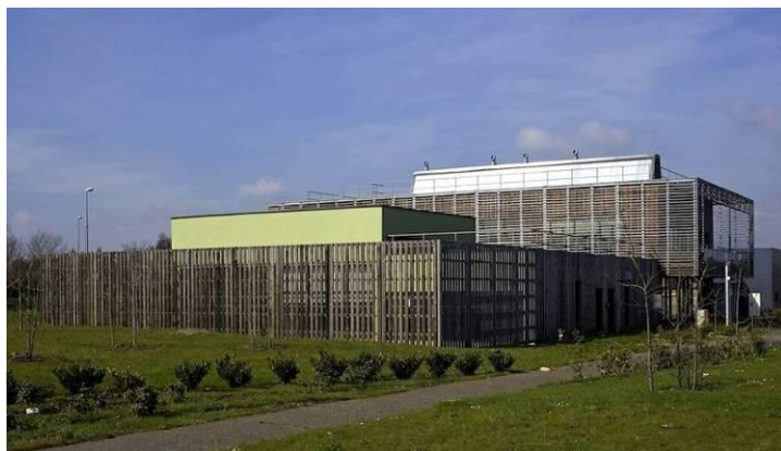
Principe d'espace technique masqué par une « double-peau » (structure métallique / bardage bois à claire-voie)
