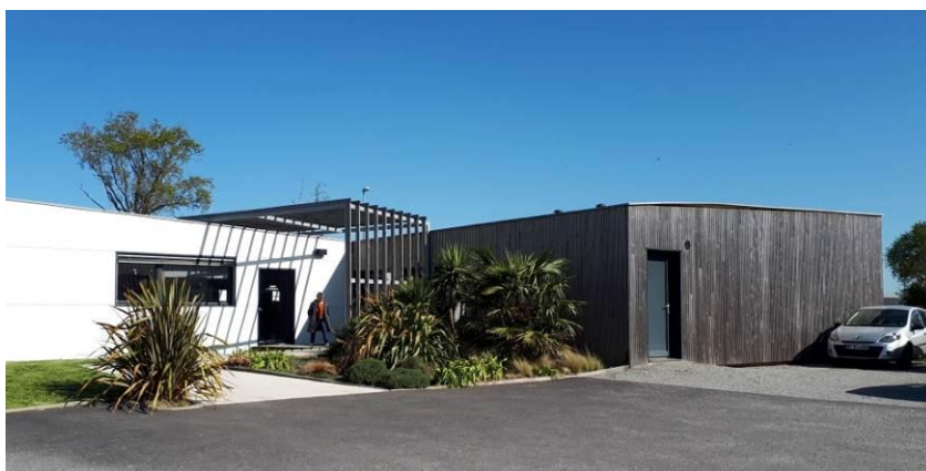
Bardage bois teinte naturelle et structure métal/ habillage bois pour identifier l'entrée
