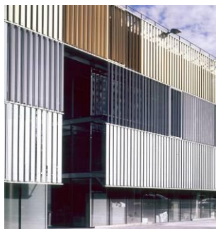
Doubles peaux métal ou bois > rôle thermique et architectural
