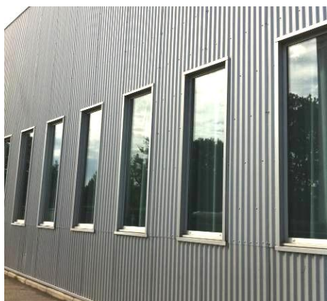
Bardage acier Fréquence 13.18 (petites ondes)
