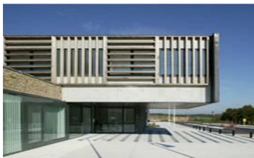
Doubles peaux métal ou bois > rôle thermique et architectural
