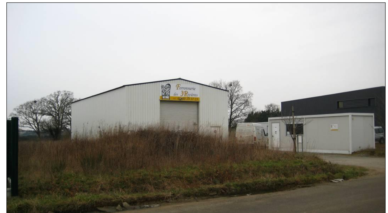
Exemple d'une butte de terre non entretenue marquant la limite de propriété.
