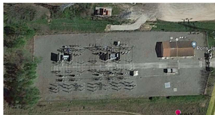
Vue aérienne Poste source de BERAT
