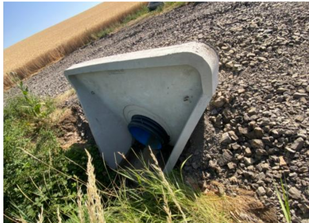
Exemple d'ouvrage de franchissement mis en place sur des chantiers de TSE
