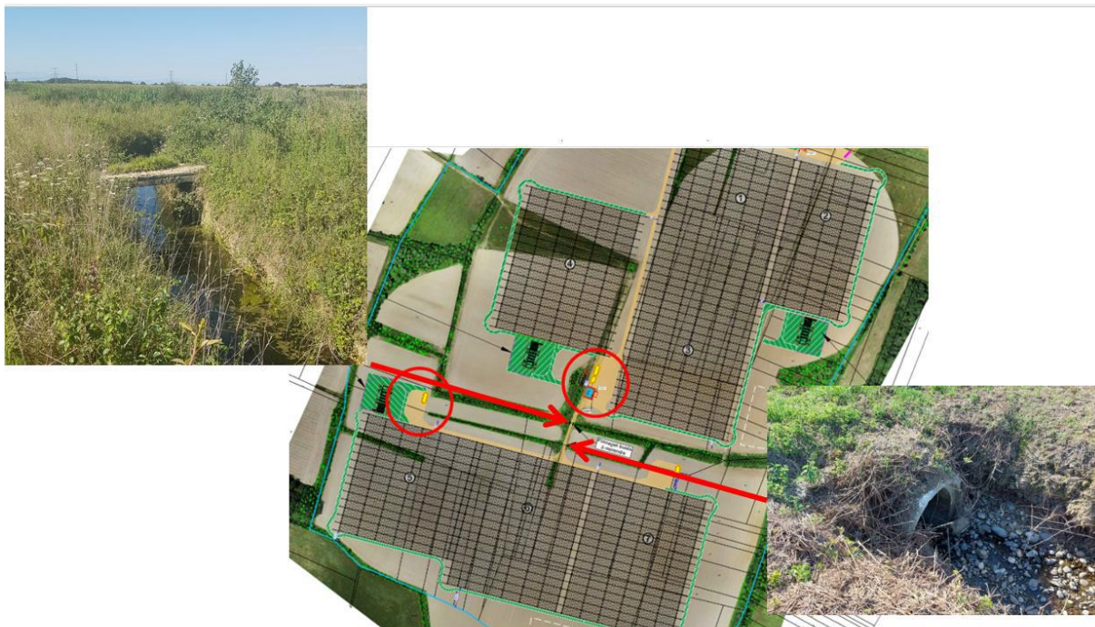
Ouvrages actuels sur site (TSE, septembre 2025)
