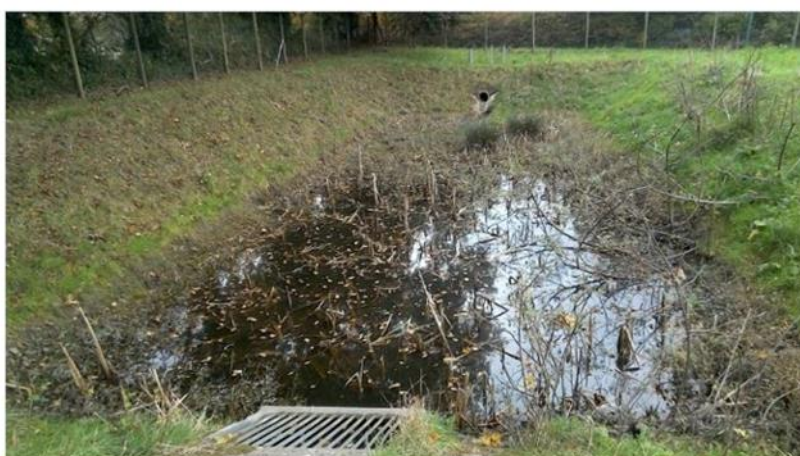
Figure 26 : Photo d'un exemple de traitement qualitatif intégré à un bassin de régulation du débit pluvial
