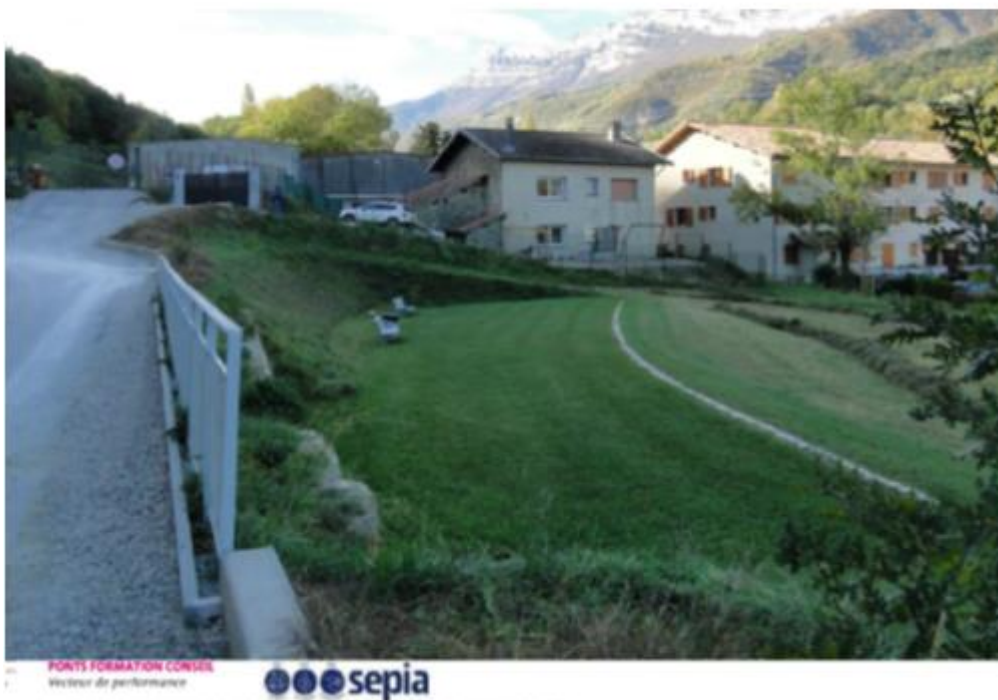
Figure 23 : Photo d'un exemple d'utilisation d'un espace vert pour le stockage et l'infiltration des eaux pluviales
