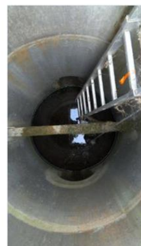
Figure 26 : Photo d'un exemple de traitement qualitatif intégré à un bassin de régulation du débit pluvial
