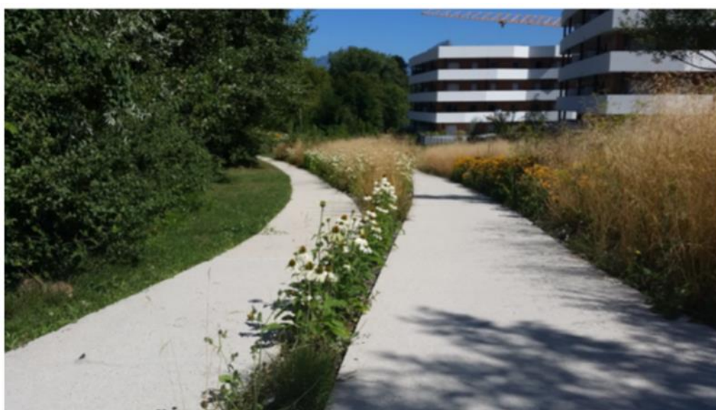
Figure 24 : Photo d'un exemple de stockage et d'infiltration des eaux pluviales le long d'un chemin piéton
