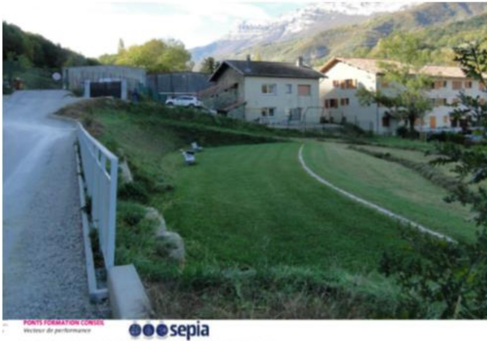
Figure 22 : Photo d'un exemple d'utilisation d'un espace vert pour le stockage et l'infiltration des eaux pluviales
