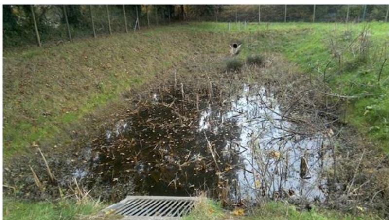
Figure 25 : Photo d'un exemple de traitement qualitatif intégré à un bassin de régulation du débit pluvial
