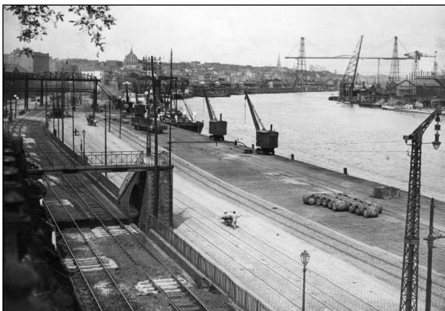
Vue du port de Nantes en 1940 (Source : Internet)
