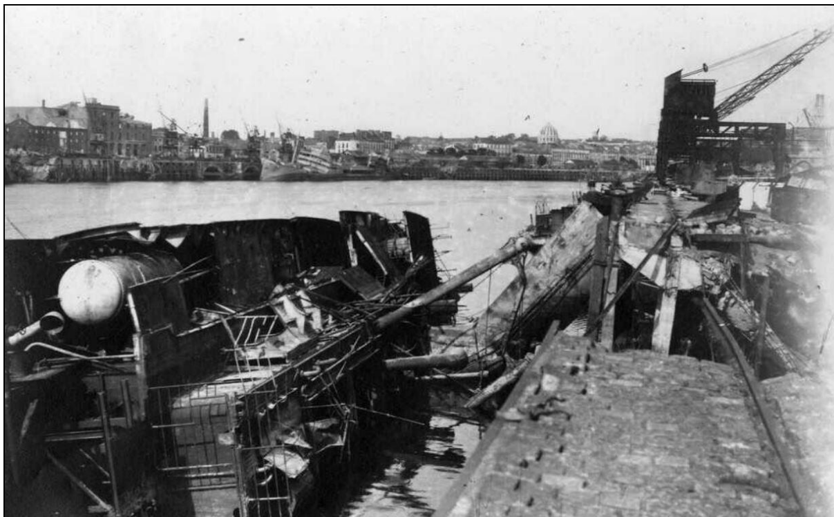
Brèche dans le quai des Antilles 16 août 1944 (Source : Archives de Nantes)
