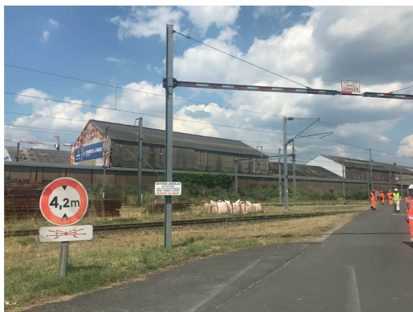
Figure 11 - Vue depuis l'entrée du site, limite de hauteur à 4,20m
