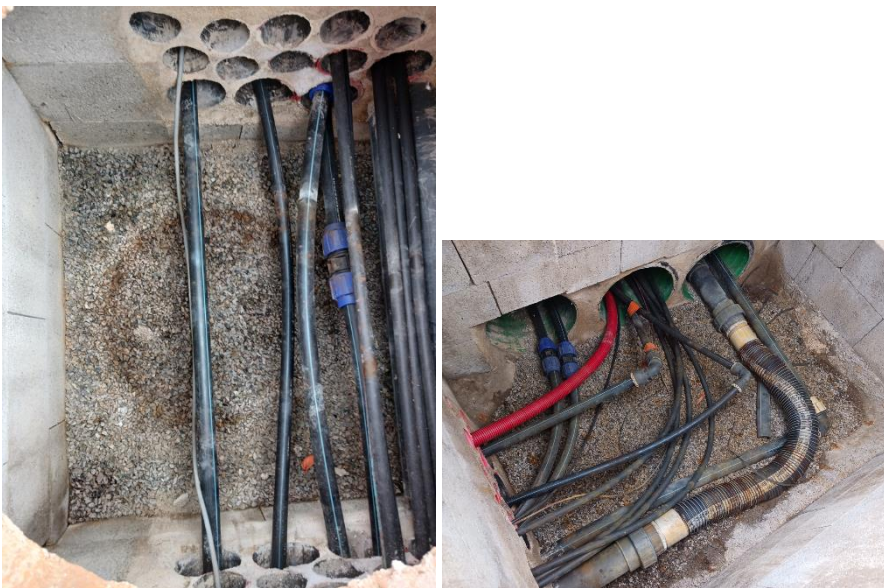
Figure 14. Réseaux en multitubulaire
