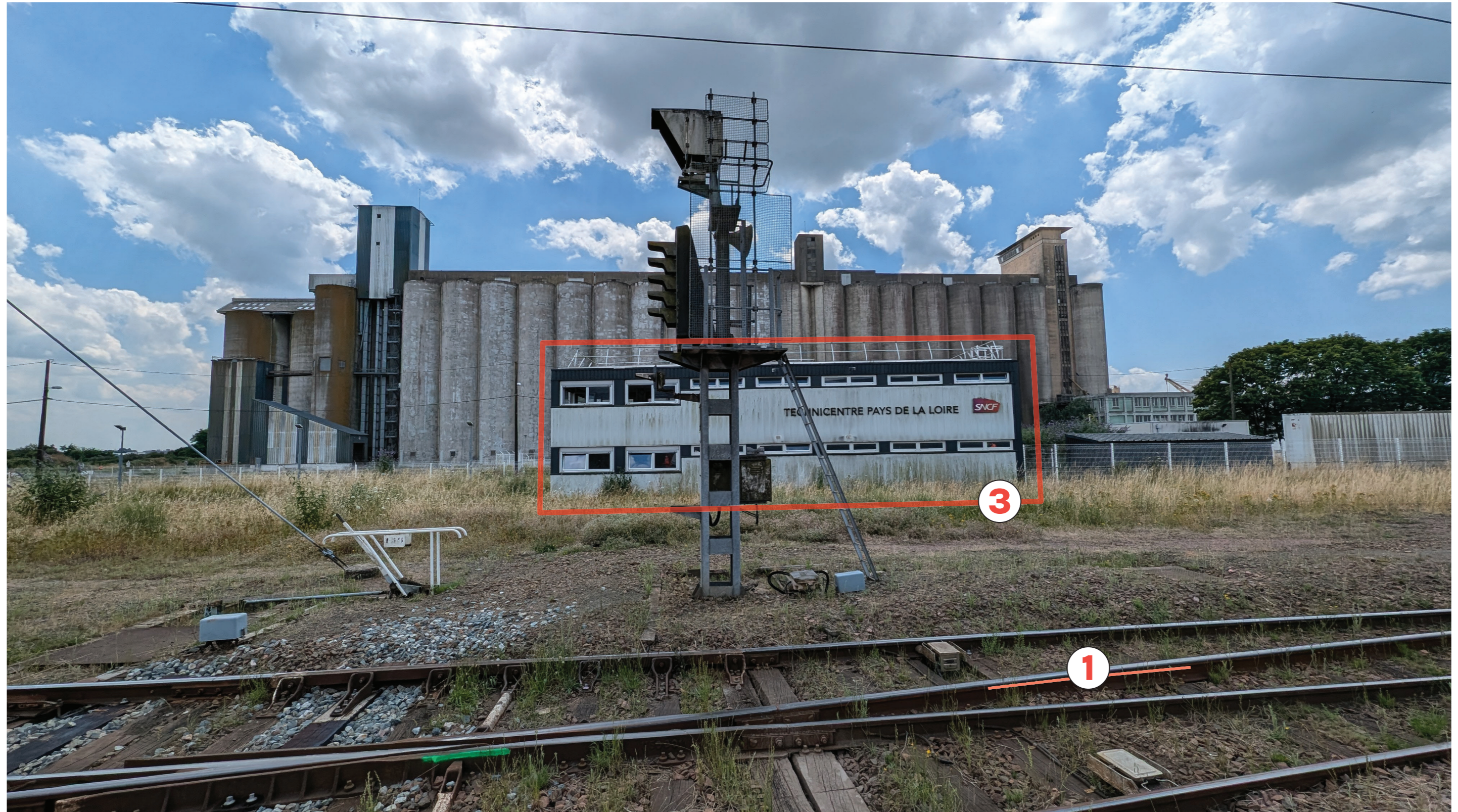
PHOTOGRAPHIES DES BÂTIMENTS A DEMOLIR
