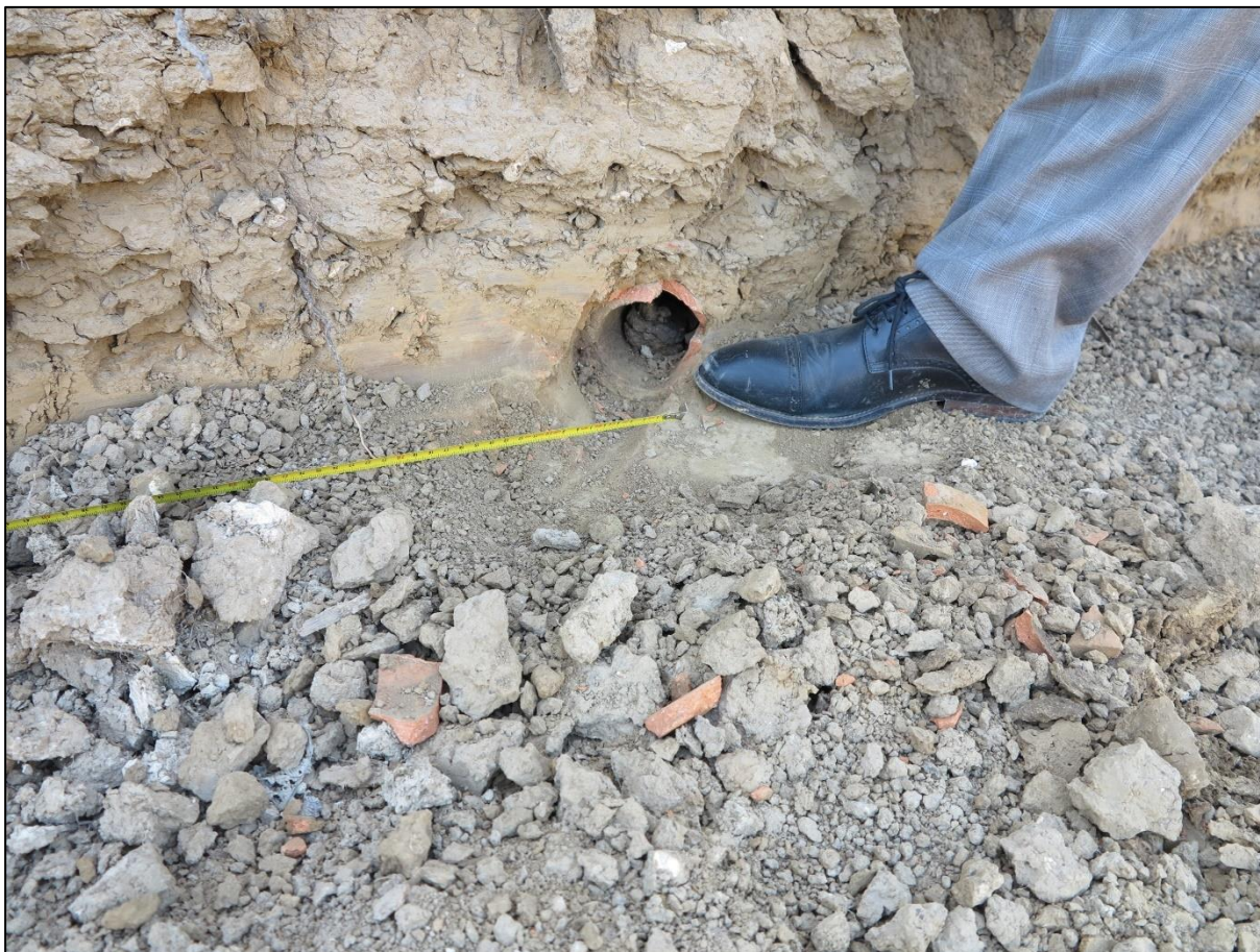
Photo 3 – Vue de la conduite en brique en bordure
