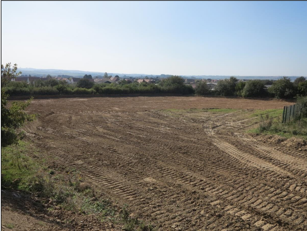
Photo 1 – Vue d'ensemble de la zone décapée
