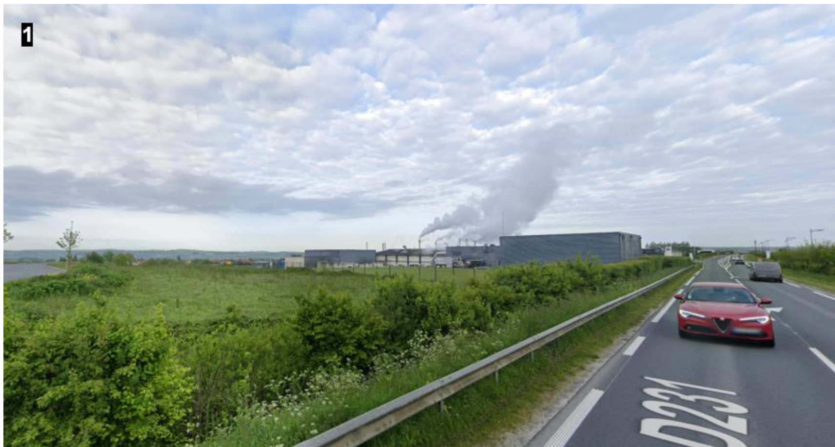
Figure 11 : Vue depuis la RD231 (source : Google StreetView, mai 2023)
