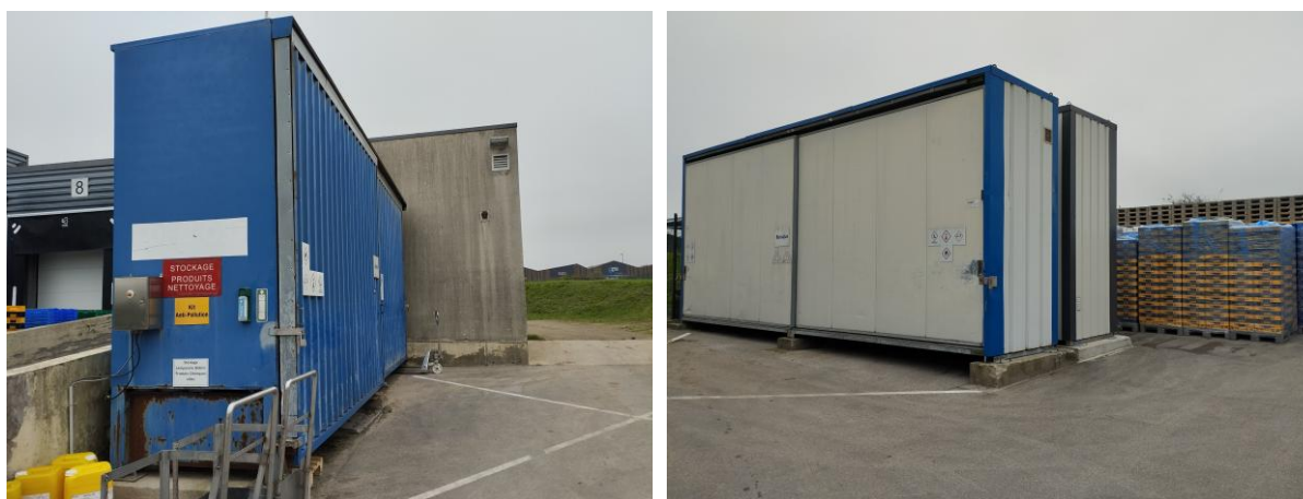
Figure 75 : Photos des conteneurs de stockage des produits chimiques
