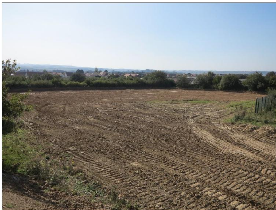
Figure 50 : Photo d'ensemble de la zone décapée (Source : GEODERIS)
