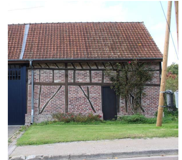
7-Bâti en colombage et briques
