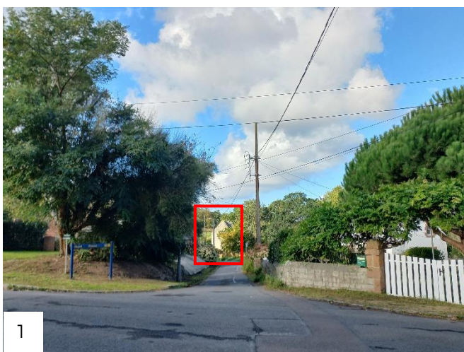
Vue sur la chapelle depuis la route de l'Île-Grande (Source : Lannion-Trégor Communauté)
