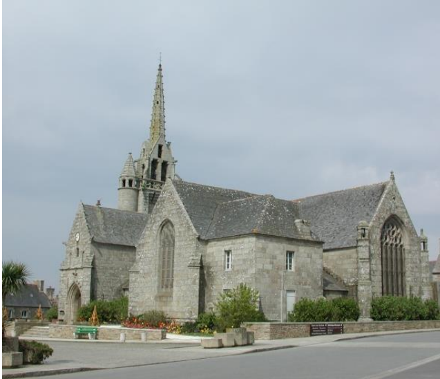
Eglise Saint-Milliau (Source : Conseil départemental des Côtes d'Armor).
