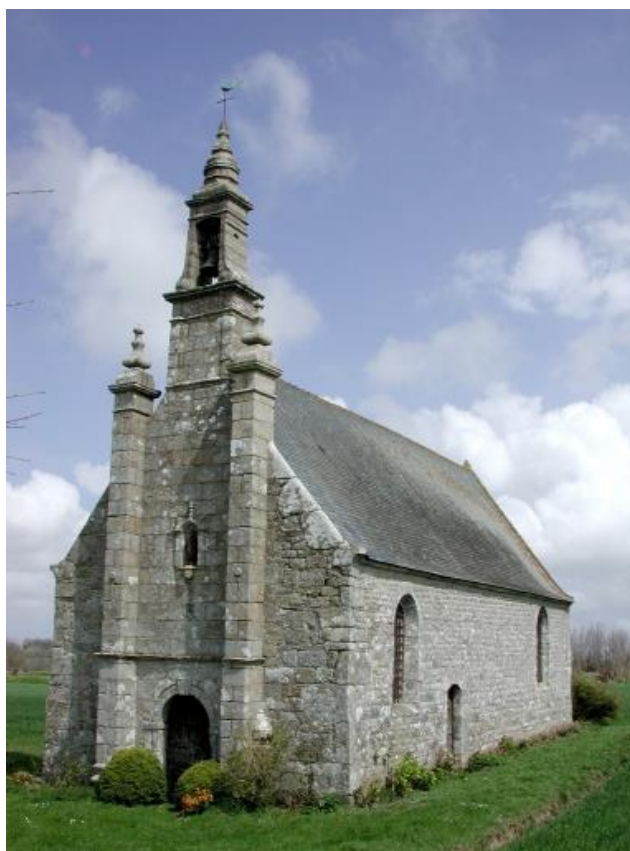
Chapelle Saint-Cado (Source : Conseil départemental des Côtes d'Armor).
