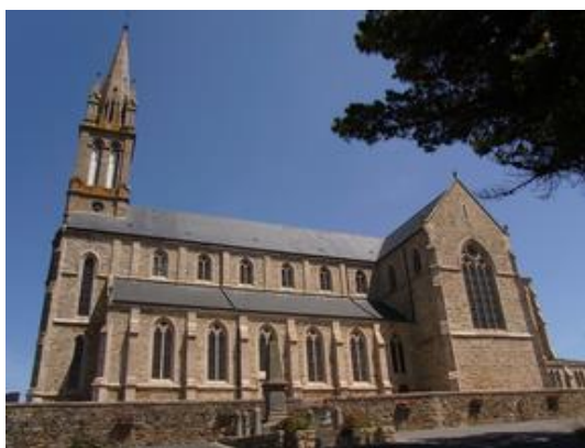
Église paroissiale Saint-Pierre; XIX ème siècle (Source : Conseil départemental des Côtes d'Armor)
