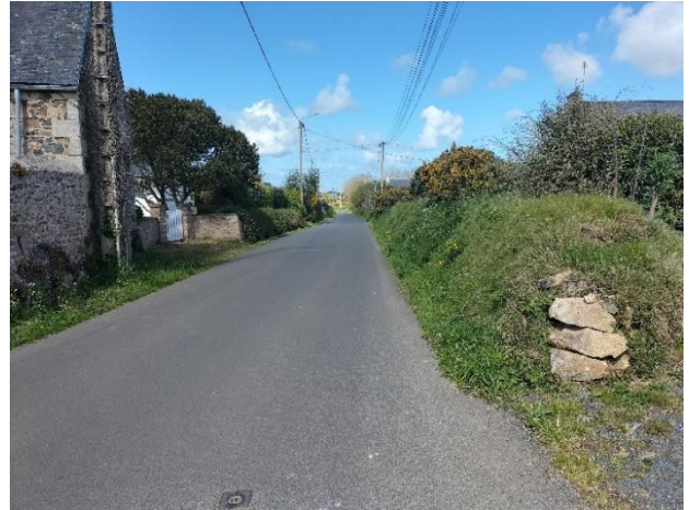
Talus-mur, rue Pempont Hent Pors Hir (Source : UDAP 22)
