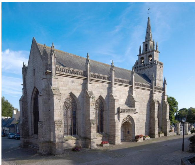
Façade latérale nord (Source : Région Bretagne).
