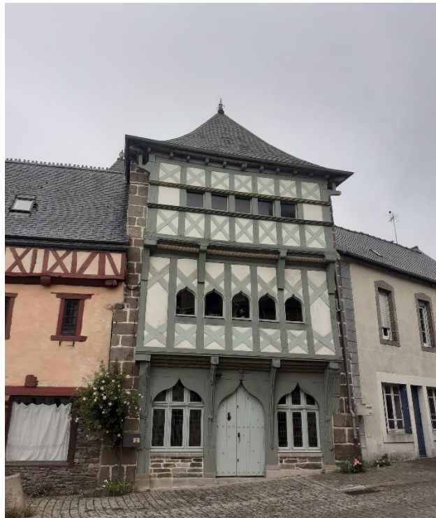
La maison de bois du XVIème siècle (Source : Lannion-Trégor Communauté).
