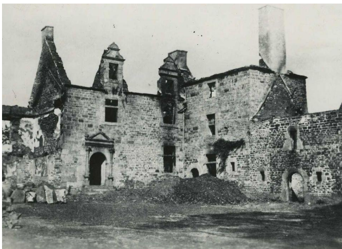
Manoir de Coat Névez incendié en 1944 (Source : Médiathèque du patrimoine et de la photographie).
