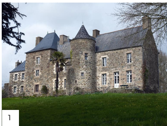
1 Château de Kermezen (Source : Conseil départemental des Côtes d'Armor)
