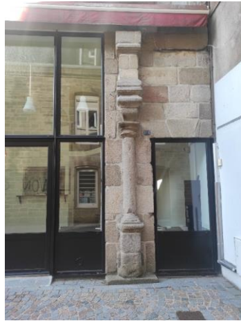
3 Colonne en pierre 11 rue Dugesclin
