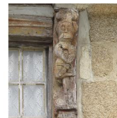
Façade en pan de bois
