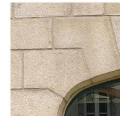
Mur en pierre de taille au rez-de-chaussée
