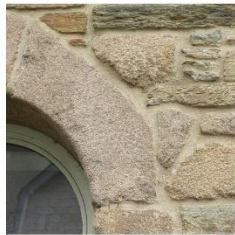
Encadrement des baies en pierre de taille
