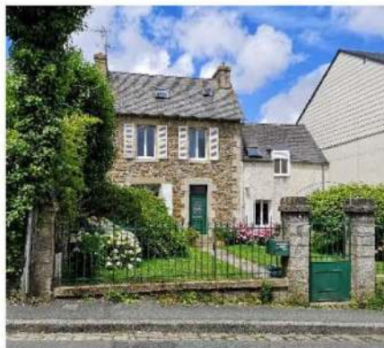
Maison rue de Rosampont ©BE-AUA
