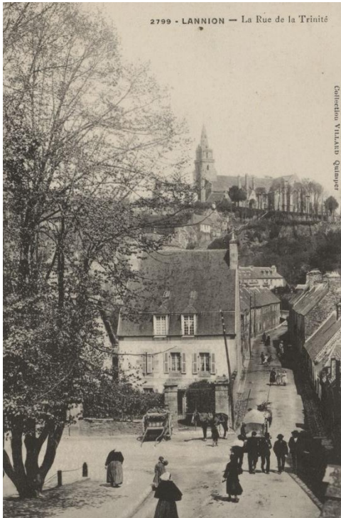
Figure 79 - [La rue de la Trinité vue depuis le sud-ouest] /[s.n.]. [1904-1908]. AD22 - 16Fi 2145
