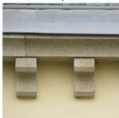
Corniche en pierre de taille
