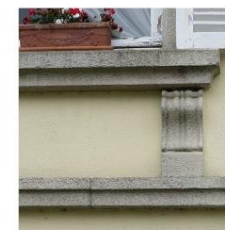
Encadrement des baies et bandeau en pierre de taille
