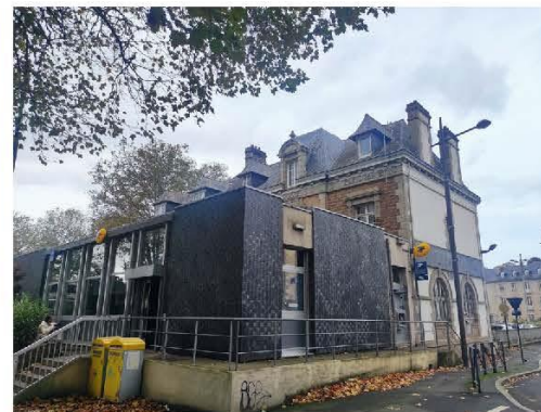
Poste, quai d'Aiguillon ©BE-AUA
