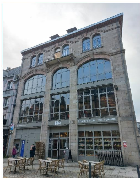
Ancien grand magasin, place du Générale Leclerc ©BE-AUA
