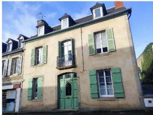
Maison rue de Tréguier ©BE-AUA
