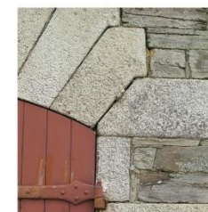
Encadrement des baies en pierre de taille
