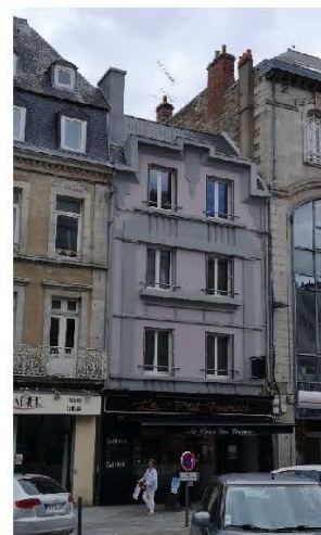
Place du Général Leclerc ©BE-AUA
