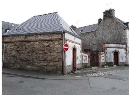
Pavillons d'entrée, demeure rue des buttes ©Région Bretagne
