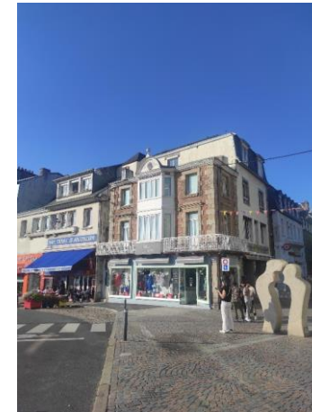
6 Tour d'escalier (chambre haute) 1 quai d'Aiguillon
