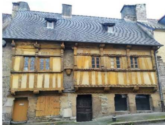
Rue de Keramont ©BE-AUA
