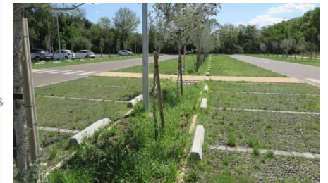
Désimperméabilisation du parking de l'université Saint-Jerôme, Marseille, La Marseillaise
