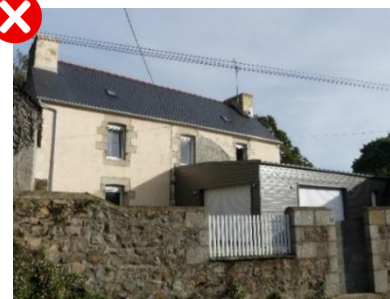
Extensions en PVC implantées sur la façade principale.
