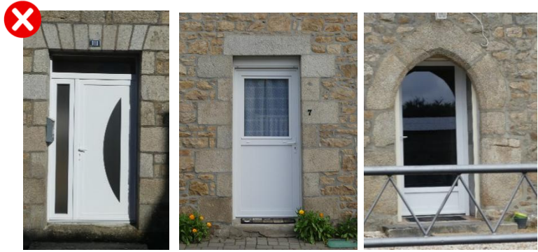
Portes en PVC blanc non adaptées à l'architecture de la construction.
