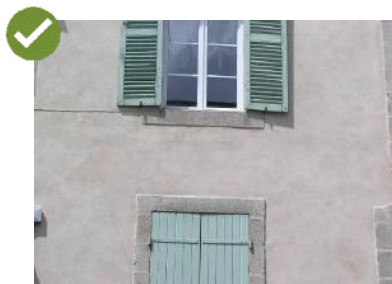
Enduit réalisé à la chaux naturelle permettant de jouer un rôle de régulateur hygrométrique et mettant en valeur les encadrements nettoyés et rejointoyés. © PACT - LTC
