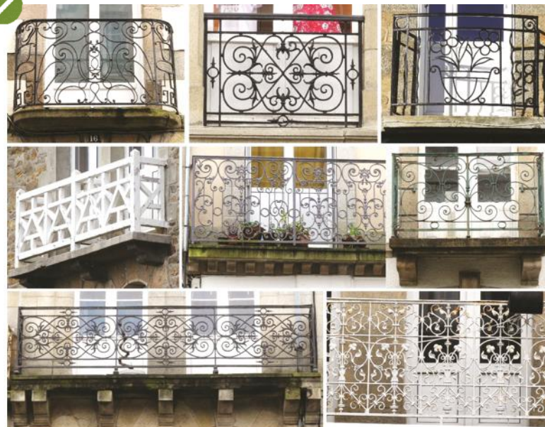
Exemples de garde-corps à conserver.
