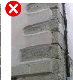
Enduit en surépaisseur. © PACT - LTC
