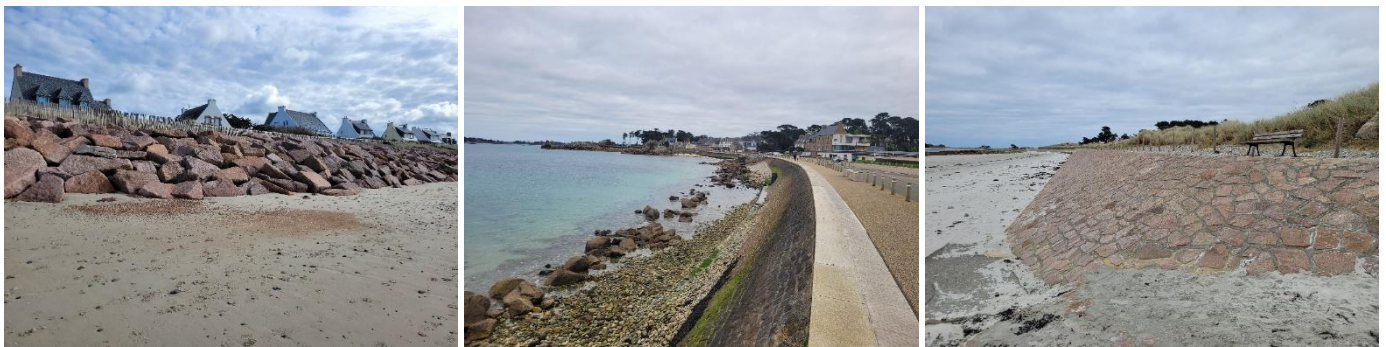
Figure 15 : exemples d'ouvrages de protection contre la mer, enrochements de la Grève Rose à Trégastel, digue du boulevard de la mer et perré des dunes à Penvénan
