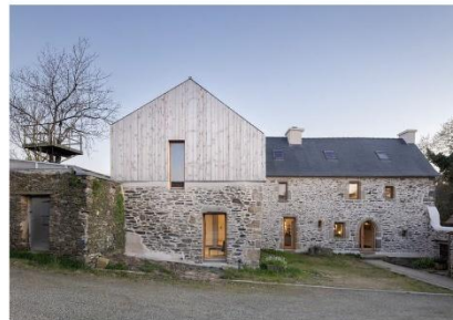
Rénovation et extension PAILLE BOIS PIERRE La Roche-Jaudy (22) B. HOUSSAIS ARCHITECTURE Sélectionné PAB 2022 © Pascal Léopold Photographe
