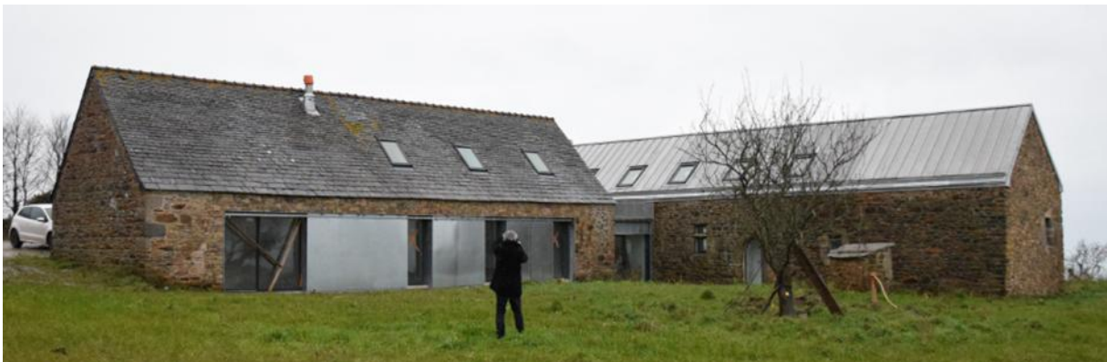
Exemple d'une construction employant des matériaux de couverture nouveaux
