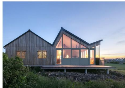
Rénovation et extension - MAISON TERRE Erquy (22) BODENEZ ET LE GAL LA SALLE ARCHITECTES Lauréat PAB 2020 © Pascal Léopold Photographe
