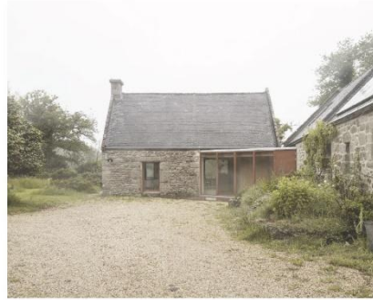
Rénovation et extension - CORPS DE FERME Briec (29) JEAN-FRANÇOIS MADEC ARCHITECTE Lauréat PAB 2025 © Celia Uhalde Photographe
