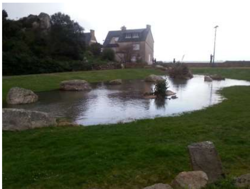
Figure N 6 : Sur le parking de la Chapelle, bassin de rétention saturé (02/2014)
