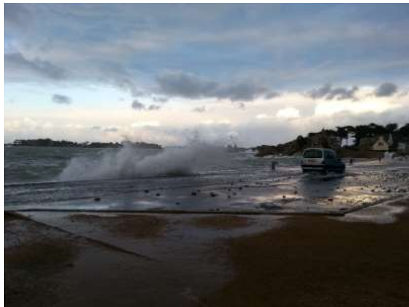
Figure N°10 : Submersion du Boulevard de la Mer (02/2014)
