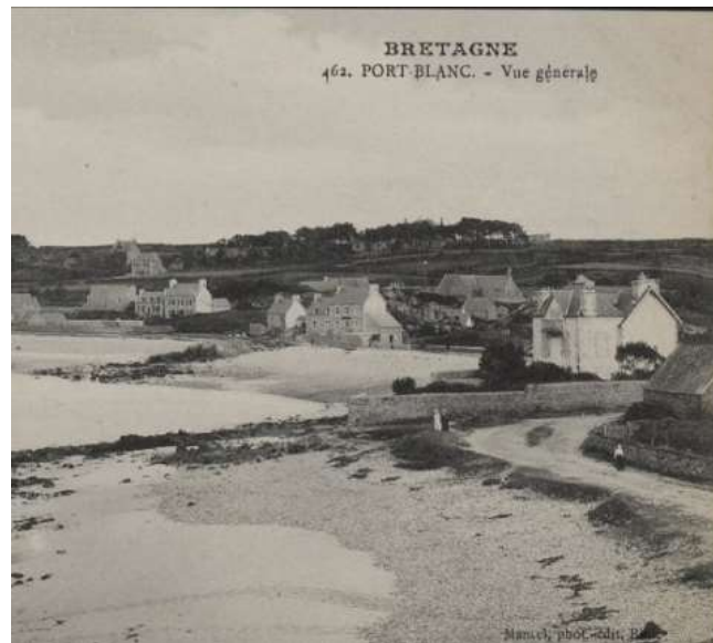
Figures N° 15 : Vue du mur ceinturant la parcelle AB 0461 (1905)
