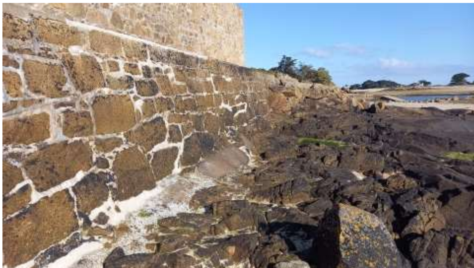
Figures N° 16 a, 16 b, 16 c : Consolidation du mur ceinturant la parcelle AB 0461
