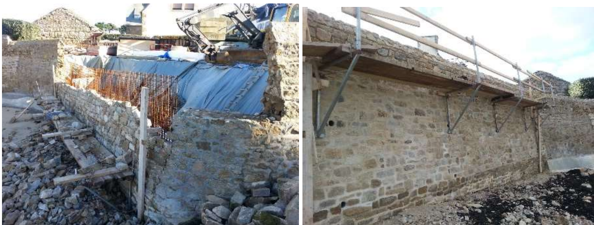
Figures N° 14 a, 14 b, 14 c : Reconstruction par un propriétaire privé du mur de protection au pied du rocher de la Sentinelle (fin 2013)
