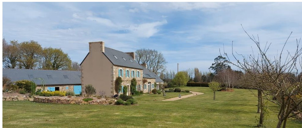
Vue du Sud-Ouest
