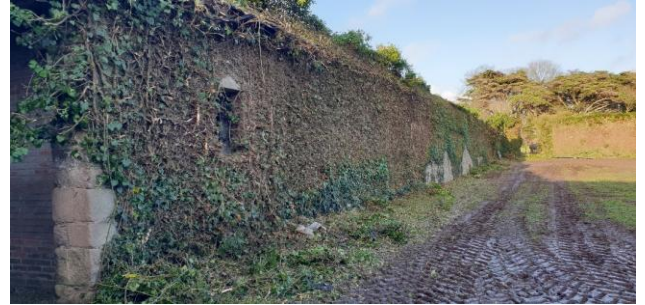
Façade intégrée dans le mur d'enceinte
