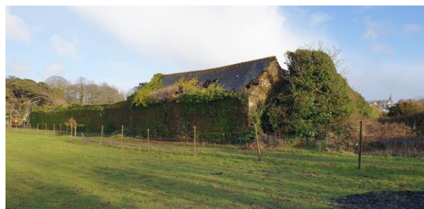
Vue depuis l'extérieur du mur d'enceinte
