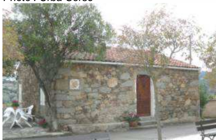
Ancien presbytère. Photo : Mérimée
