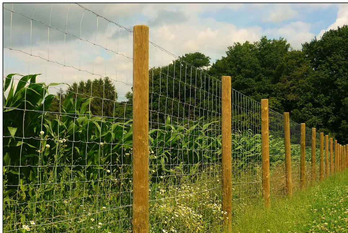
Clôture composée de piquets bois et d'un grillage en acier galvanisé hauteur 2m, passages pour la petite faune (20x20cm) en partie basse
