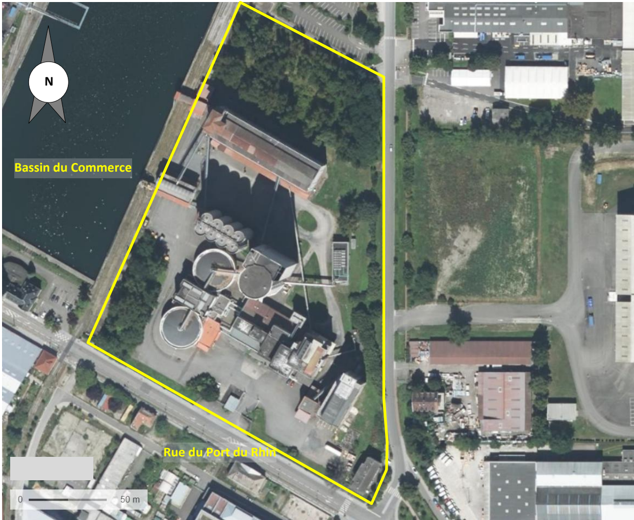
Figure 2 : Vue aérienne du site étudiée (échelle graphique)
