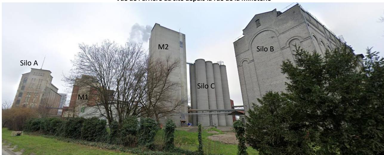
Vue de l'arrière du site depuis la rue de la Minoterie
