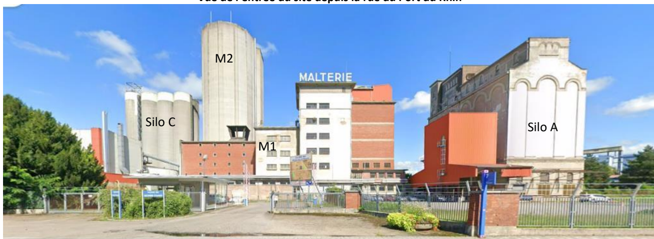
Vue de l'entrée du site depuis la rue du Port du Rhin
