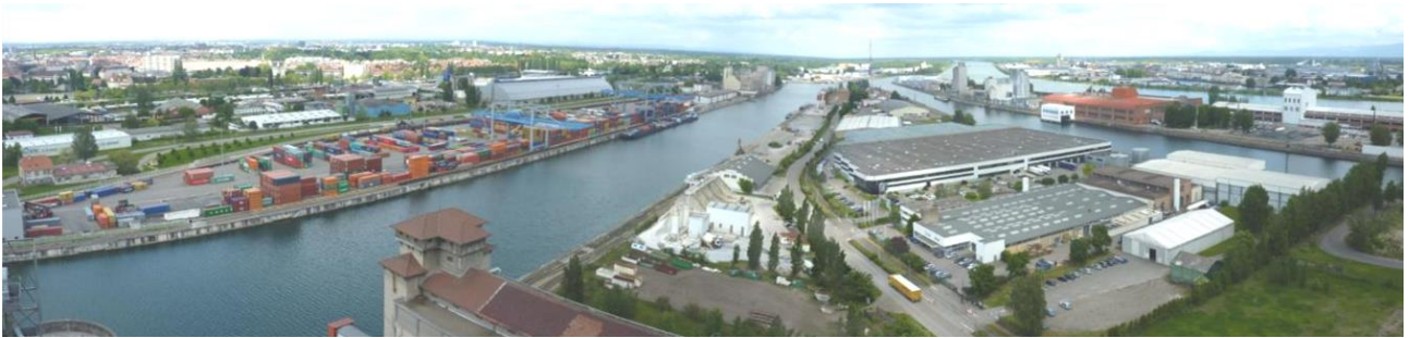
Vue vers le Nord : sites industriels et bassin du Commerce
