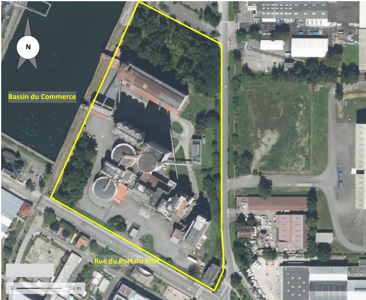
Figure 2 : Vue aérienne du site étudiée (échelle graphique)
