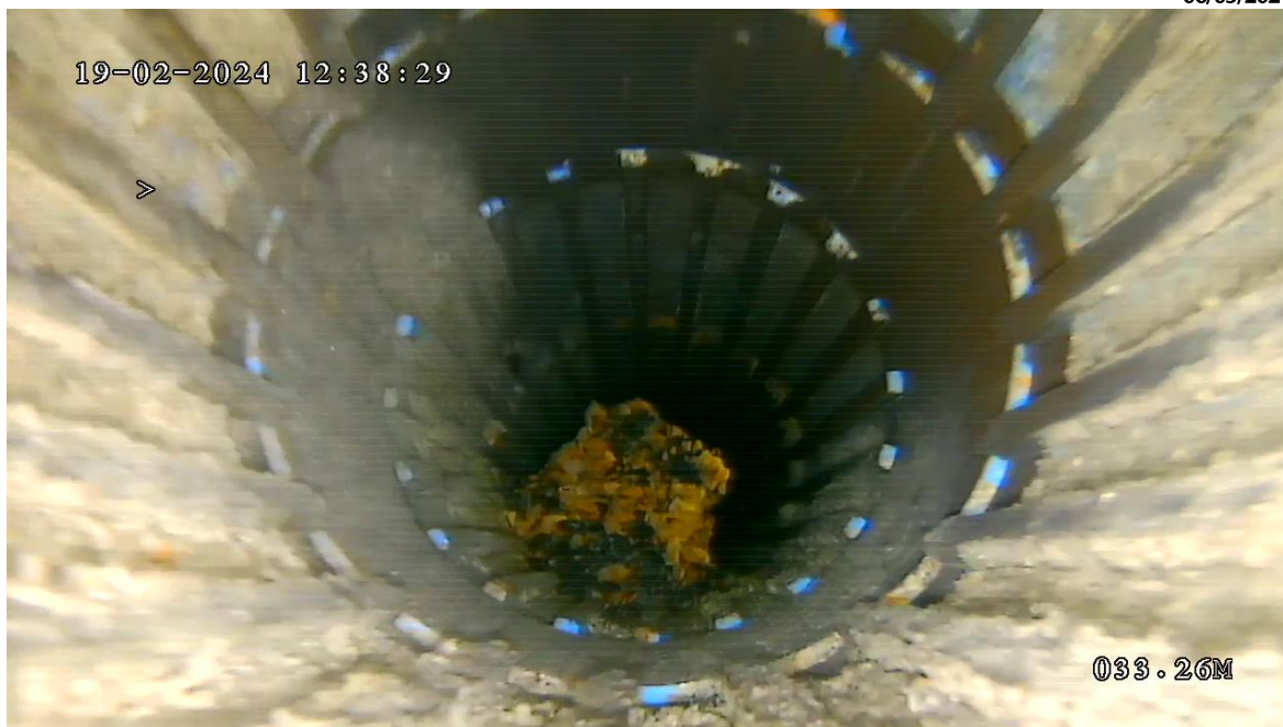
Dépôts noirs et encroûtements et tube en fond de trou couvert d'encroûtements ocres (Oxydes et/ou carbonates de Fer)
