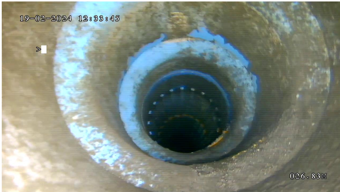
Réduction de diamètre et début des tubes crépinés
