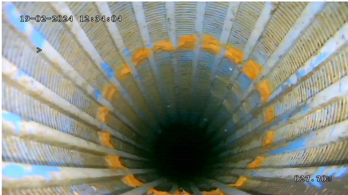
Encroûtements localisés d'oxydes de fer
