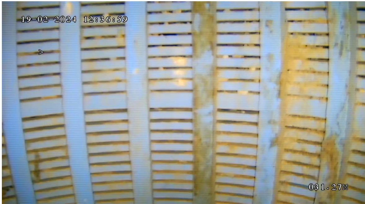
Fentes visibles et gravier à l'extrados
