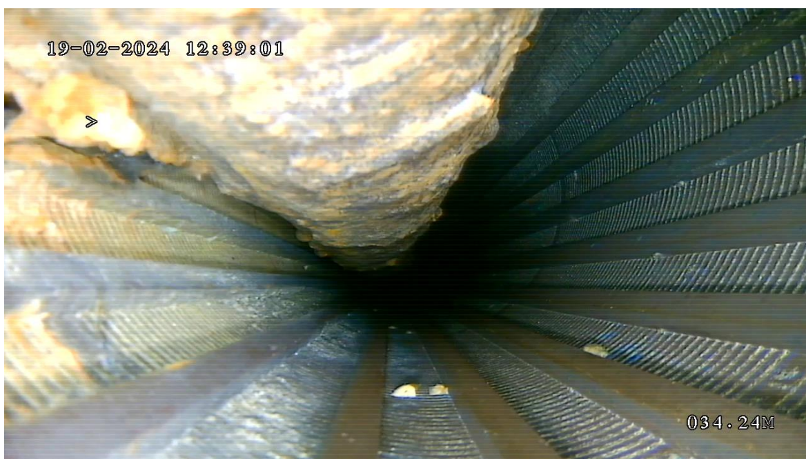
Tube totalement recouvert et dépôts d'oxydes de manganèse sur les crépines
